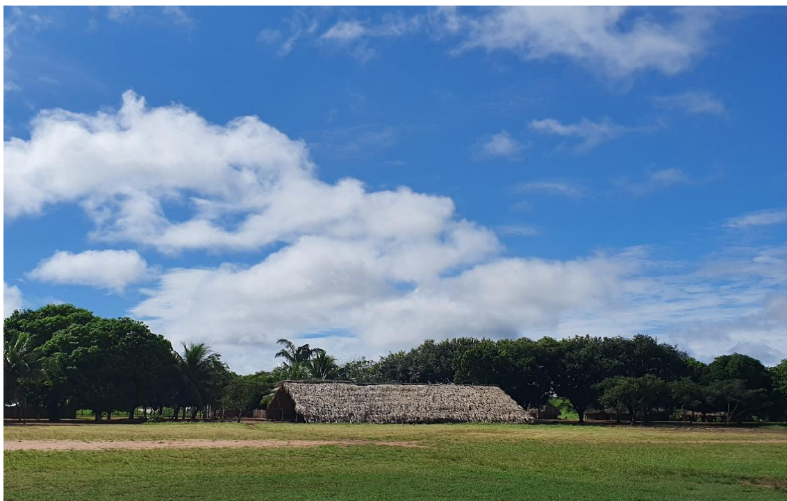
Fotografia de minha autoria. Vista da grande casa tradicional em construção na aldeia Ilha Grande para ser usada para as festas da comunidade. Ilha Grande, março de 2020.
