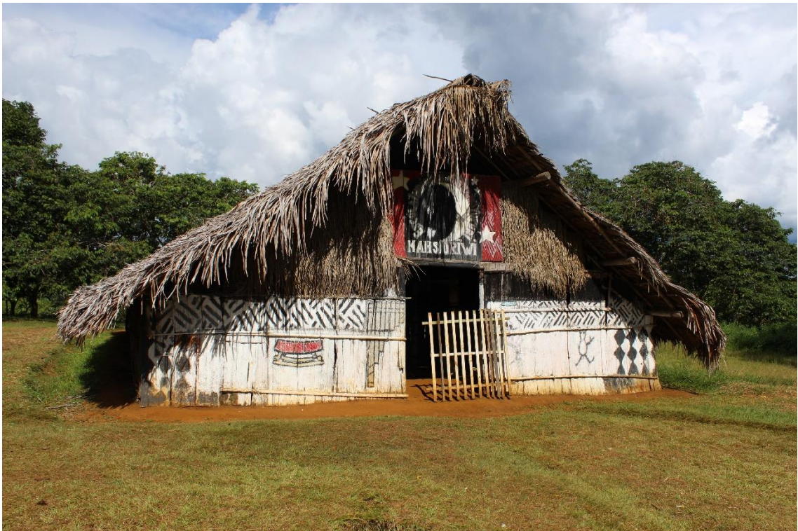
Imagem 6: Vista externa da Bahseri'wi na comunidade de São José II
