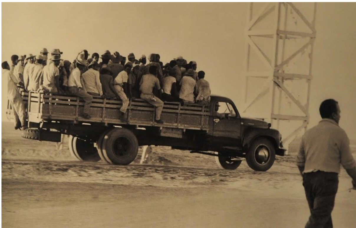
Figura 30: Caminhão transportando operários durante a construção de Brasília
