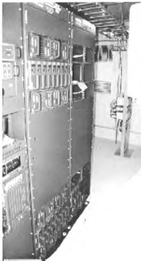
Figura 2.4 - Interior de uma ERB, bastidor de Rádios
