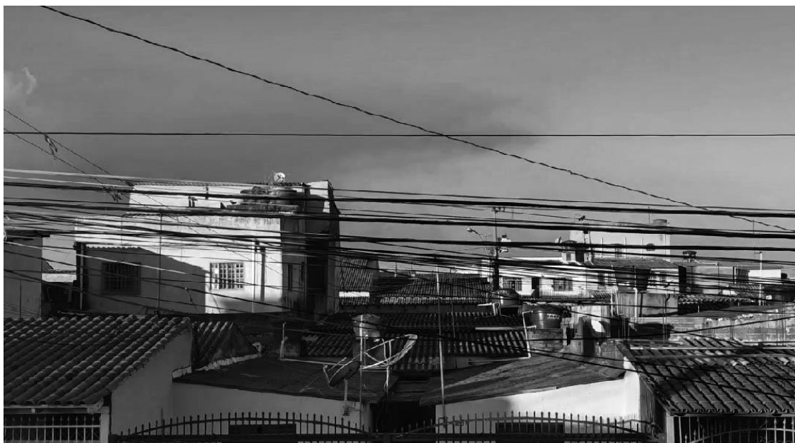
Cenário 100 – Vista da laje.
