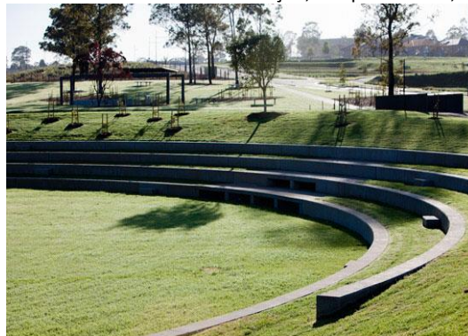
Figura 12 – Anfiteatro bacia de detenção, Parque Redfern, Sydney.
