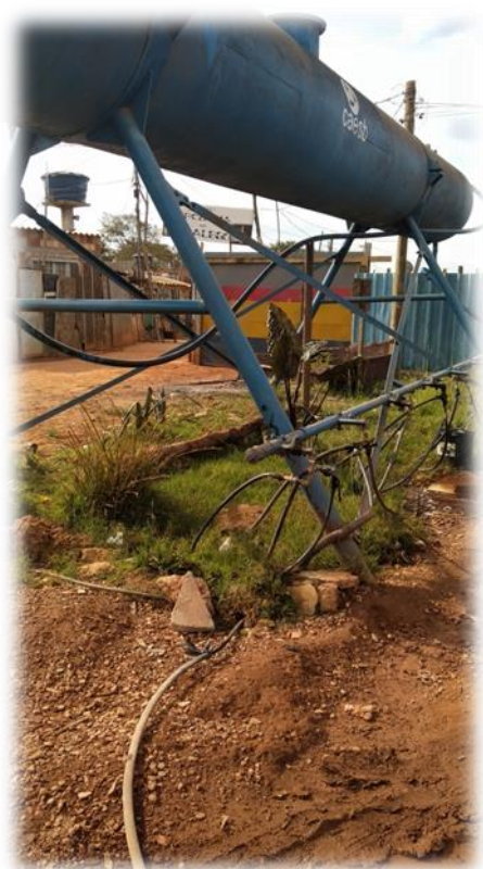
Figura 9 - Chafariz que abastece o setor Santa Luzia.
