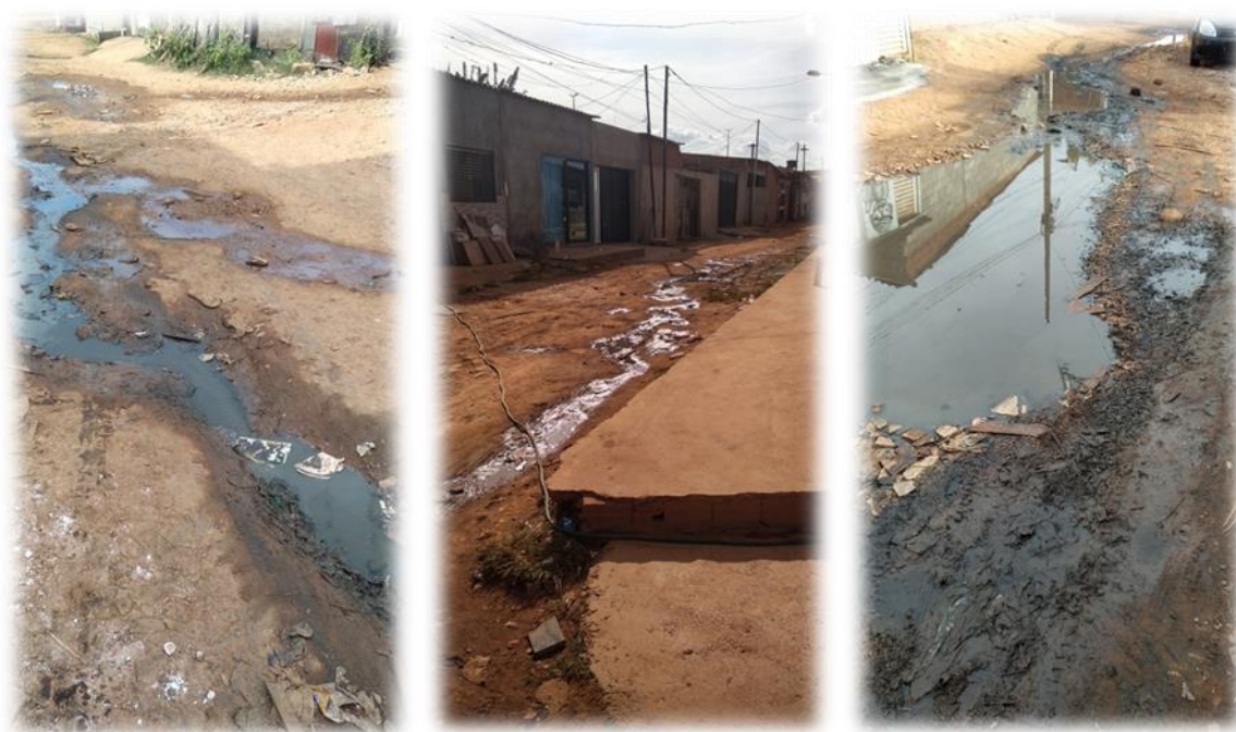
Figura 8 - Esgoto a céu aberto no setor Santa Luzia.
