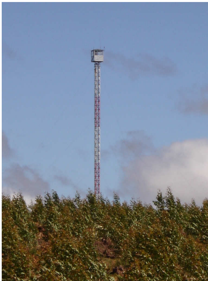
Foto 8 – Torre de controle em meio ao maciço de eucalipto.
