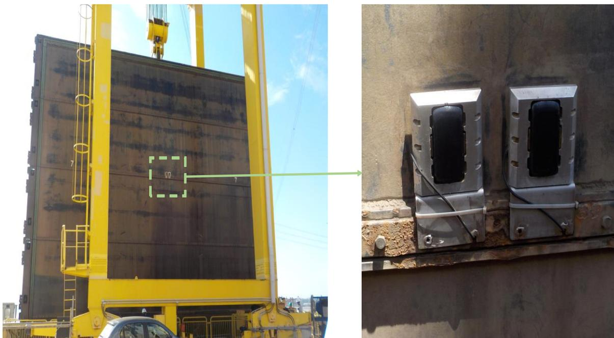
**Fig. 2** - Sistema hidroacústico acoplado ao plano de face da comporta vagão da UHE Jirau (Patente nº BR 102015000457-5 A2 / [www.venturoconsultoria.com.br](http://www.venturoconsultoria.com.br)). (DIAS; MAROJA; GARAVELLI, 2020)
