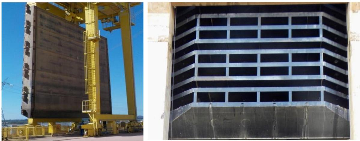
**Figura 2:** Imagem fotográfica do plano de face e detalhamento das estruturas de fundo/gavetas da comporta vagão utilizada no procedimento operacional de fechamento do tubo de sucção durante parada da unidade geradora. (Fonte: acervo Venturo Consultoria)
