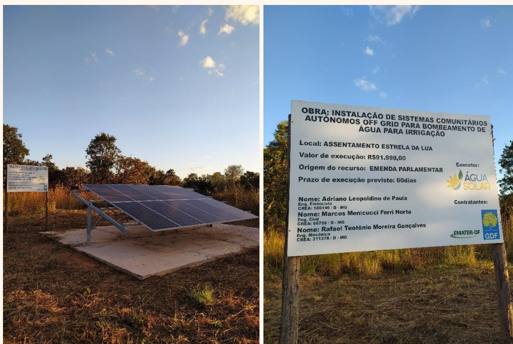
Figuras 9 e 10: Instalação de energia fotovoltaica no assentamento Estrela da Lua .
