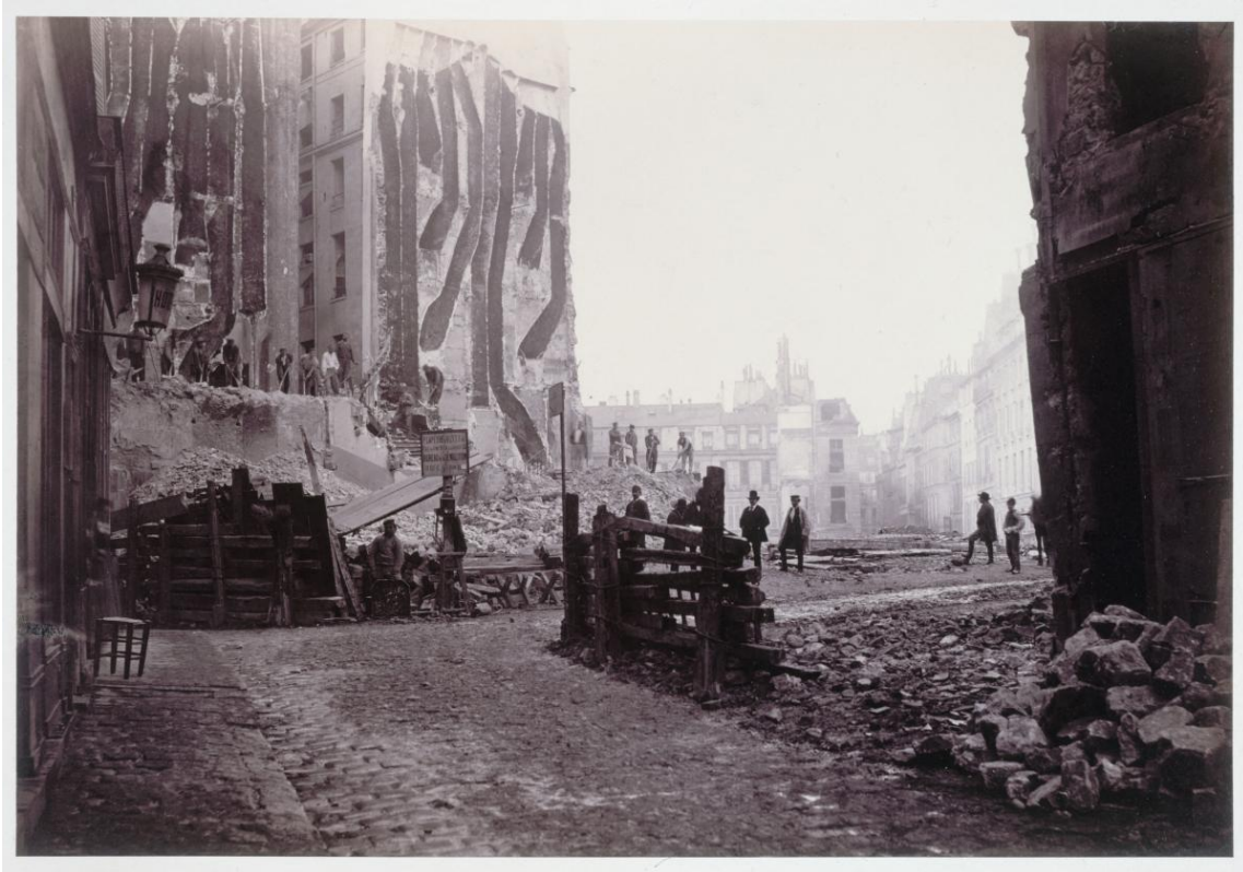
Fig. 4 Canteiro de obras da rua d'Argenteuil , 1876, Charles Marville.
