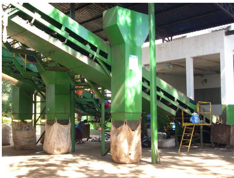
Fotografia 18 – Instalações de uma Usina de Triagem em Brasília Autor: Nepomuceno Data da foto: 2008
