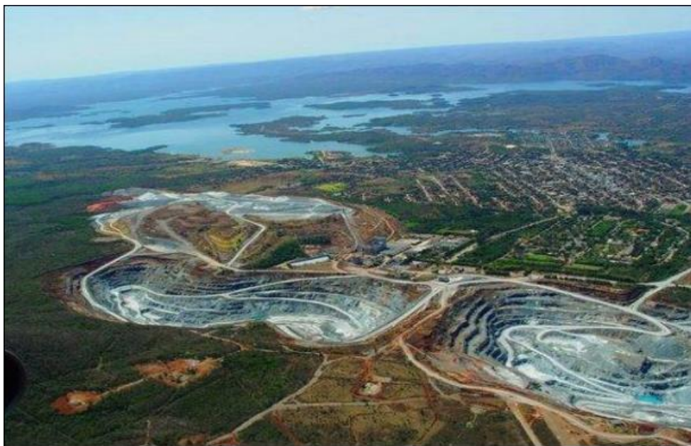
Figura 11 – Vista aérea da cidade de Minaçu, onde pode ser observado ao fundo o Lago da UHE de Cana Brava e a frente as cavas da mineração realizada pela empresa SAMA.
