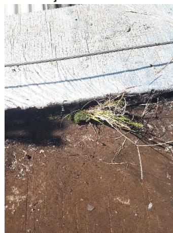
Figura 55 – Vegetação na impermeabilização externa do reservatório.
