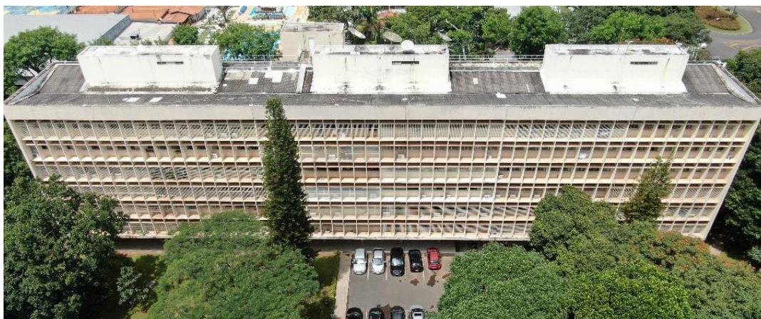
Figura 65 – BLOCO F da SQS 108. Vista Fachada Frontal.
