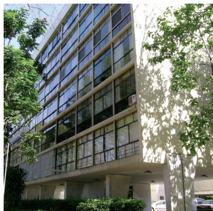
Figura 35 – Fachada envidraçada – tipo de blocos AFA-4 e AFB-4.
