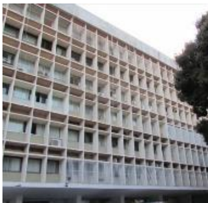
Figura 34 – Fachada com quebra-sol em concreto armado – AFA-2, AFB-2 e AFA-3.
