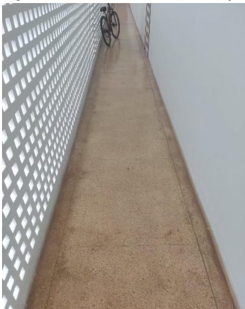
Figura 74 – Piso do corredor de serviço.
