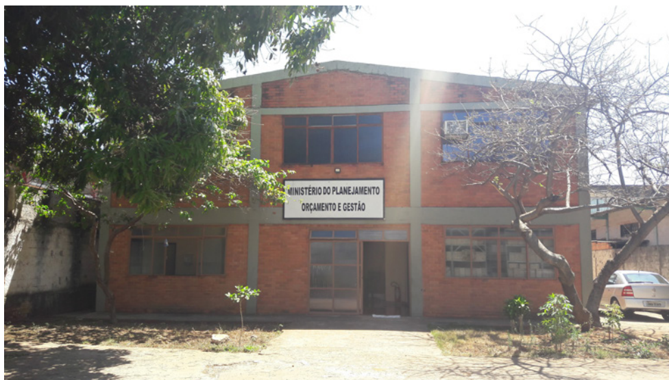
FIGURA 1: Prédio do Ministério do Planejamento no SIG, em Brasília, utilizado como depósito para armazenamento de parte dos documentos das empresas estatais liquidadas.
