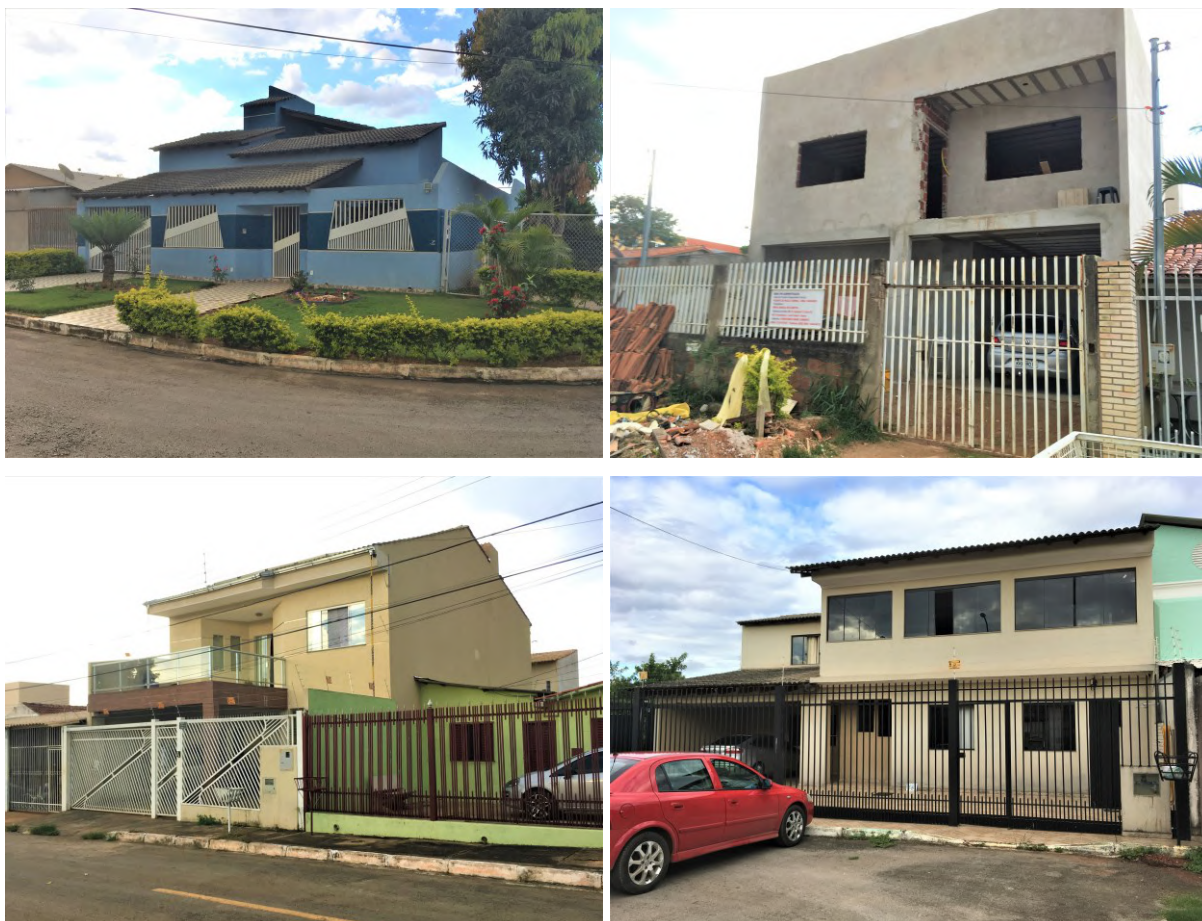
Figura 100 – Casas reformadas e reconstruídas
