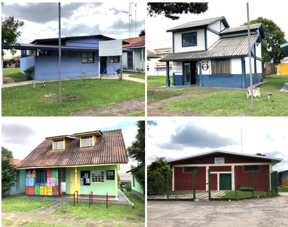
Figura 49 – Equipamentos comunitários da Rua das Tecnologias em Curitiba
