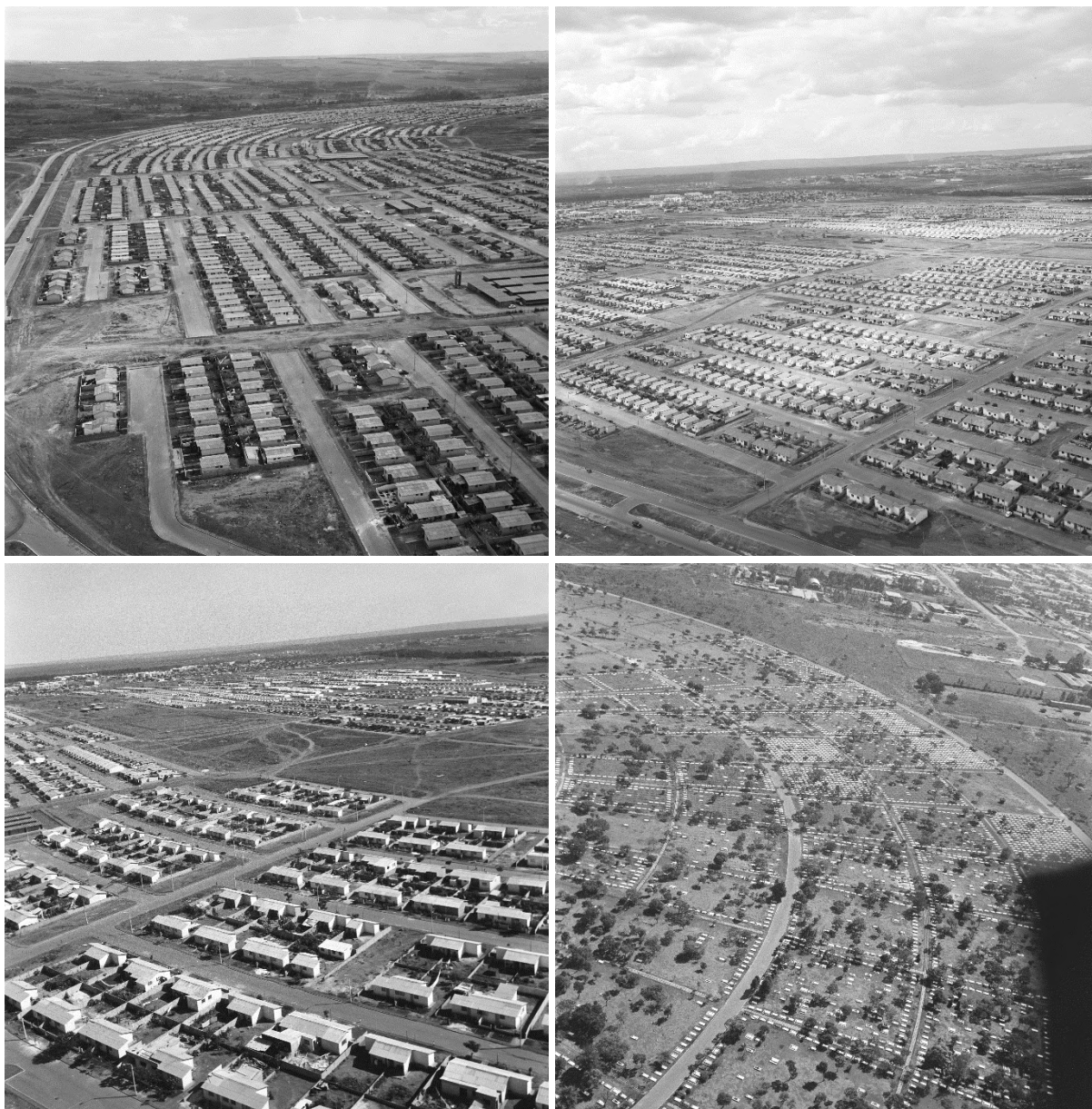
Figura 12 – Fotos aéreas do Guará II em construção
