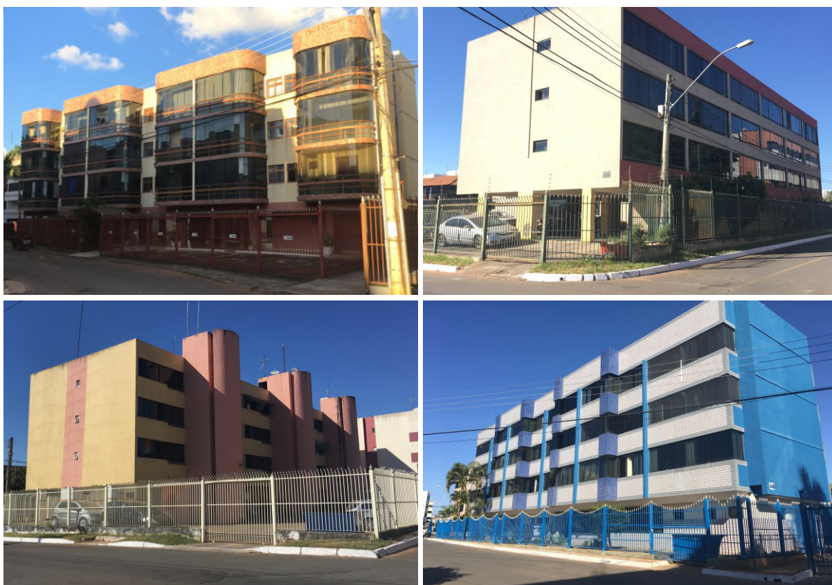
Figura 33 – Blocos de apartamentos das QE 2, 3 e 4
