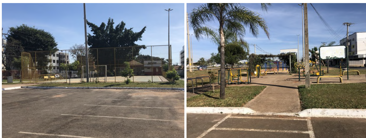
Figura 104 – Áreas de lazer instaladas na Vila Tecnológica
