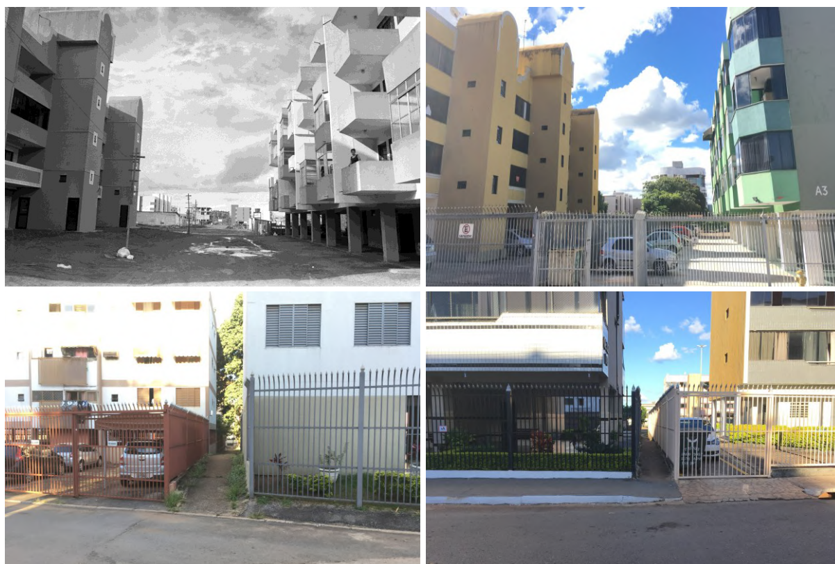
Figura 30 – Fotos dos pilotis cercados e becos entre as grades
