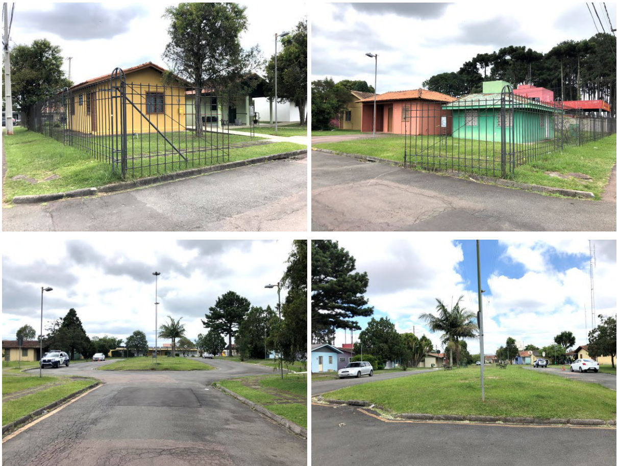
Figura 48 – Fotos atuais da Rua das Tecnologias em Curitiba
