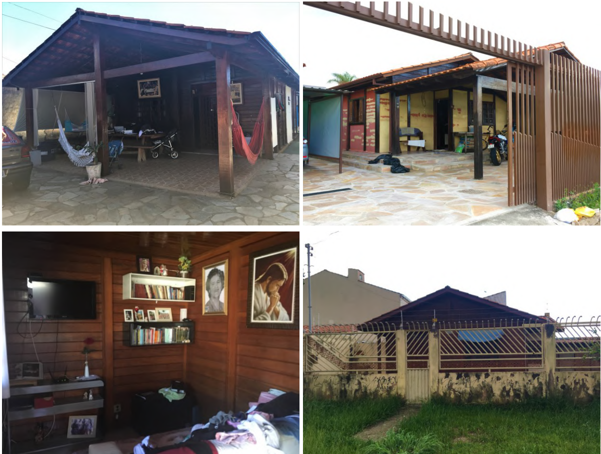
Figura 88 – Fotos casas da Vale Alto Construtora (Madeira)
