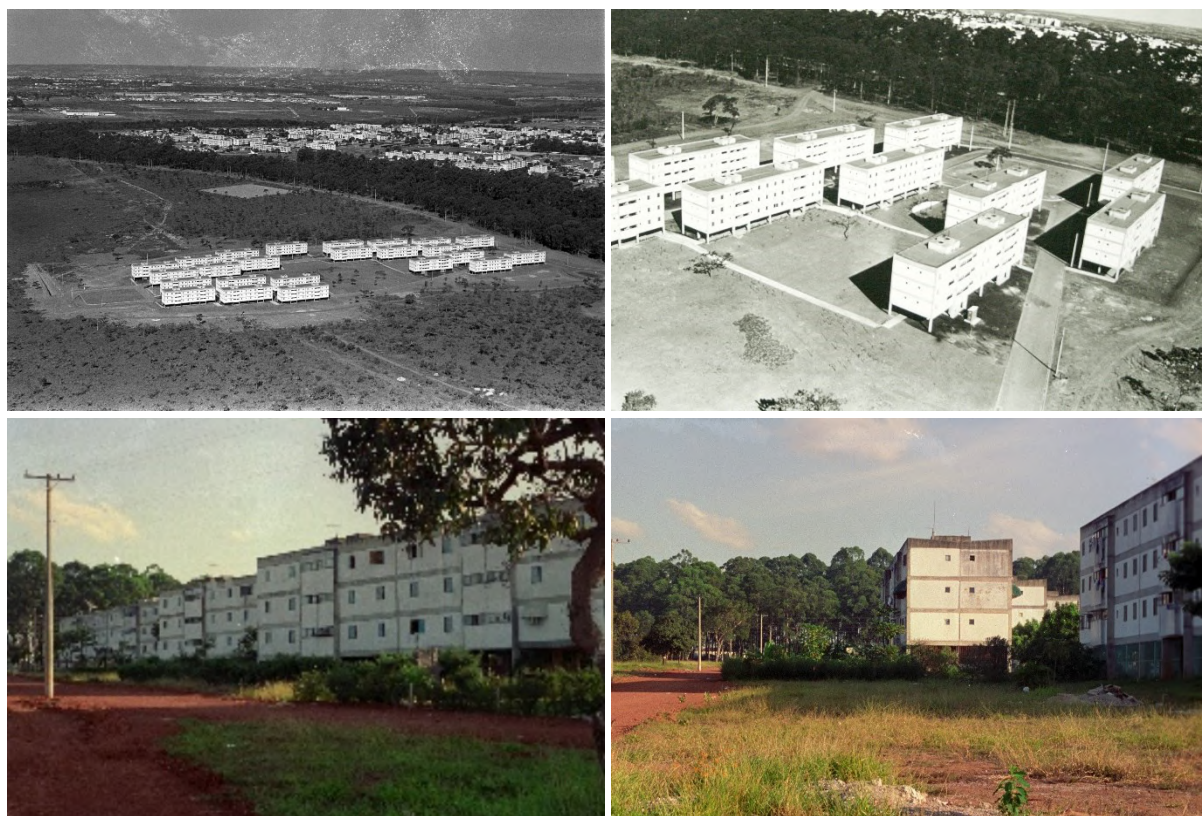
Figura 26 – Fotos dos blocos da QE 01 na época de construção
