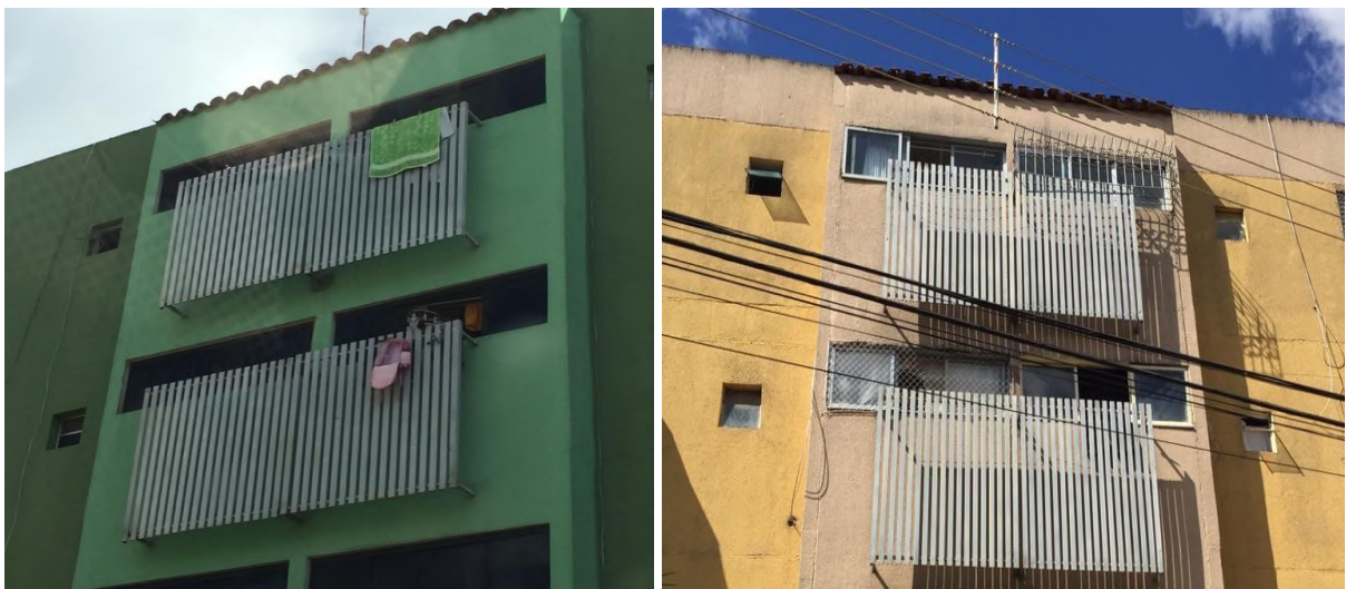
Figura 28 – Jirau: elemento na fachada para secagem de roupas
