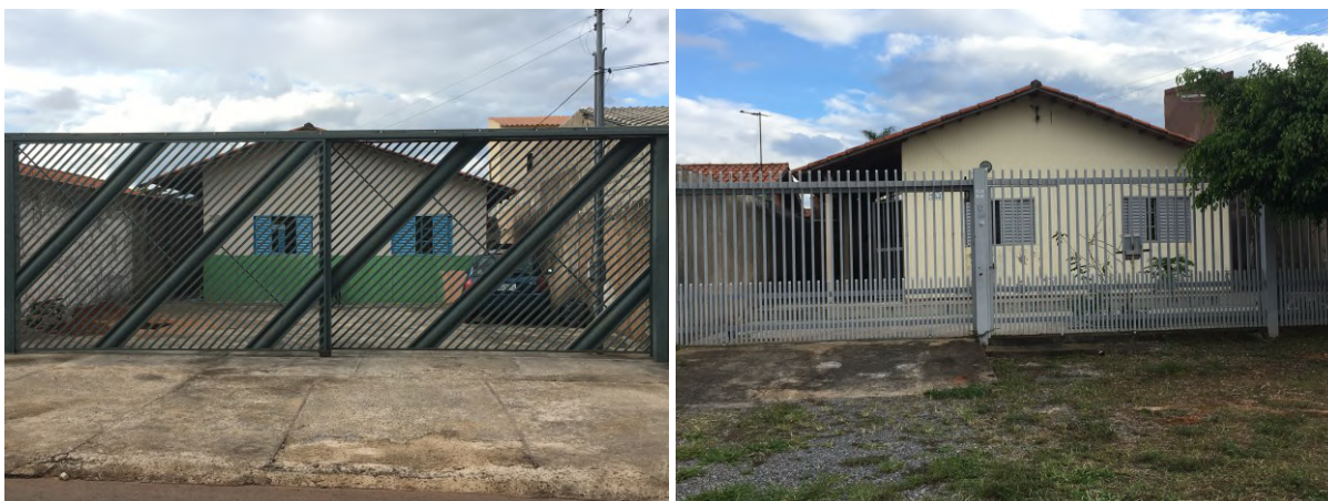
Figura 87 – Fotos casas da Vale Alto Construtora (Concreto)
