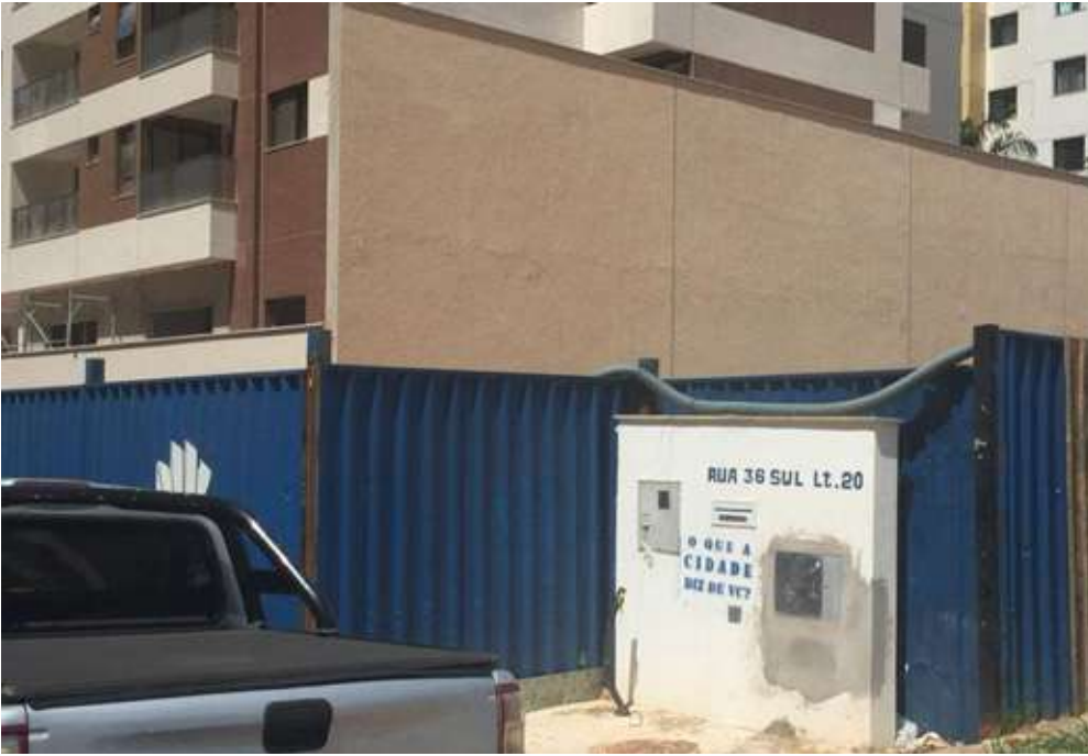
Figura 151 – Stencil na caixa de energia, 2021
