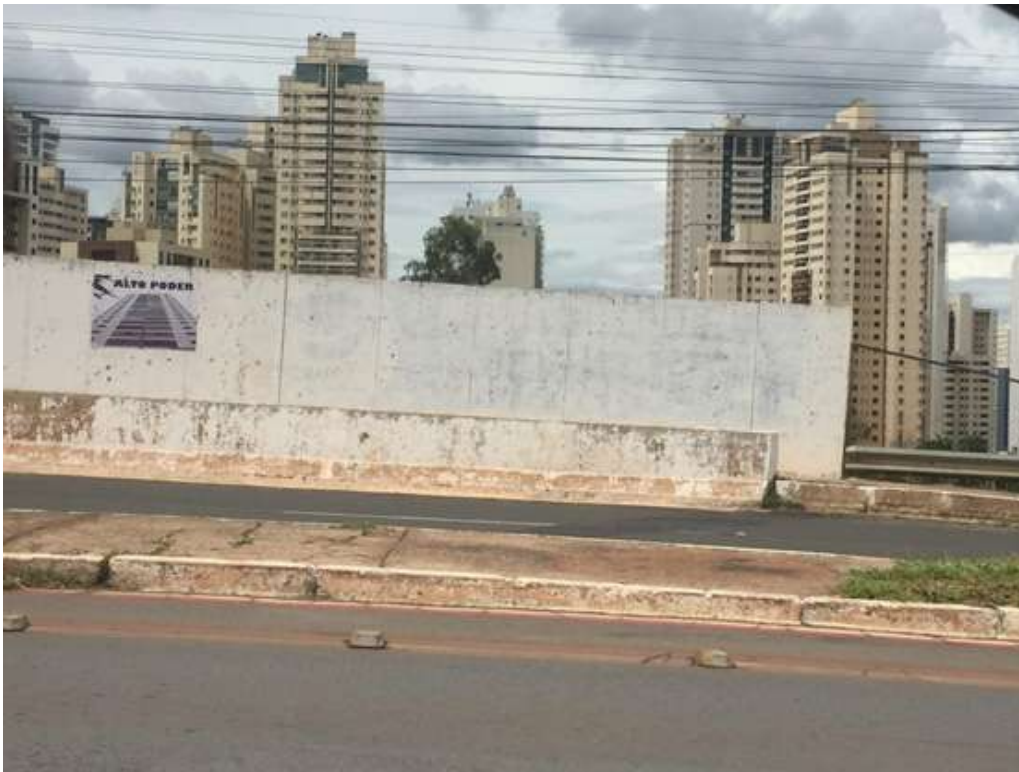
Figura 135 – Lambe grudado na passagem da Av. Araucárias, entre a rua 28 sul e a Av. Sibipiruna. 2020
