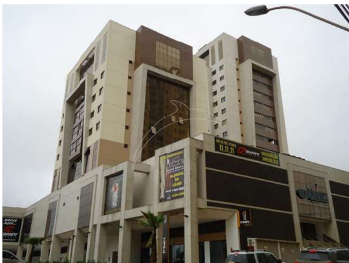
Figura 47 – Shopping One Park Mall, na rua das Paineiras.
