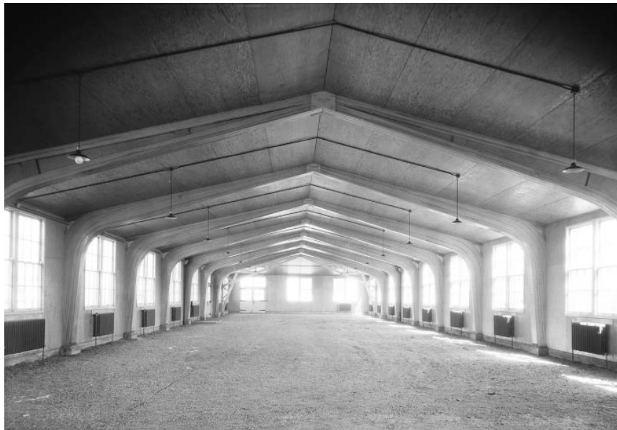
Figura 2. Construção do FPL (USDA, 1999).
