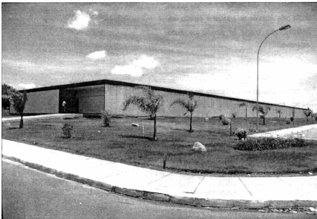
Foto 8 fachadas sul e leste
