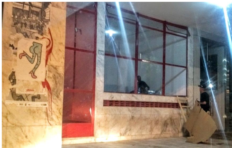
MUDA – Vista parcial da intervenção no vidro da Galeria de Bolso da Casa da Cultura da América Latina. 2020
