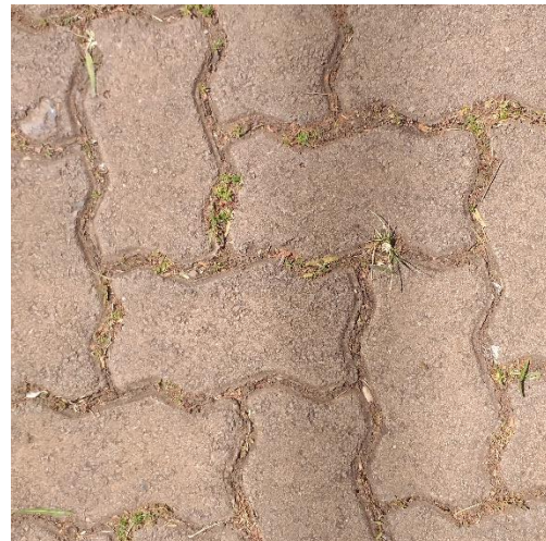
Concreto intertravado estacionamento
