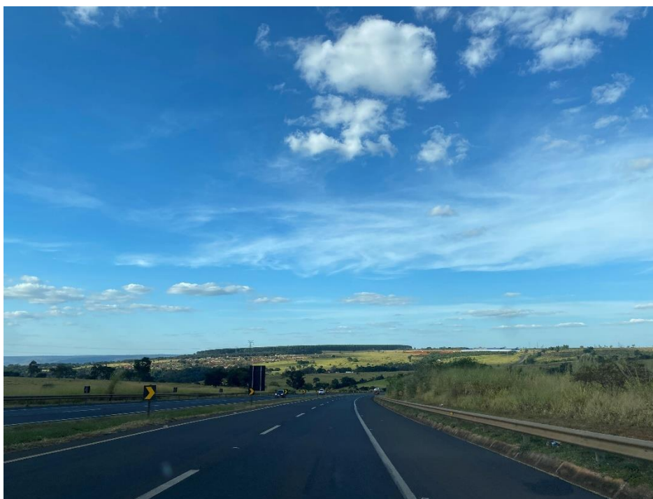
Figura 31. Uberlândia – MG: vista sentido leste do Anel Viário
