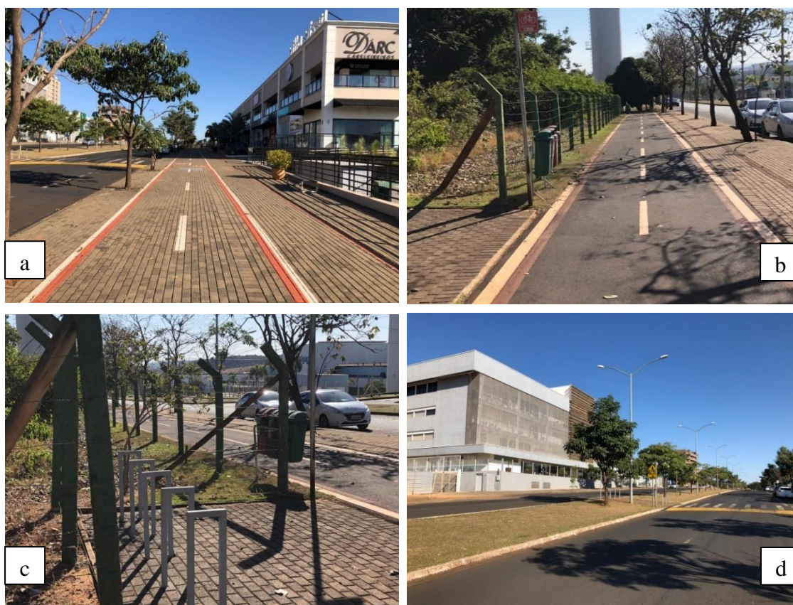
Figura 22. Uberlândia – MG: ciclovias, equipamentos e perspectiva do sistema viário no Bairro Granja Marileusa
