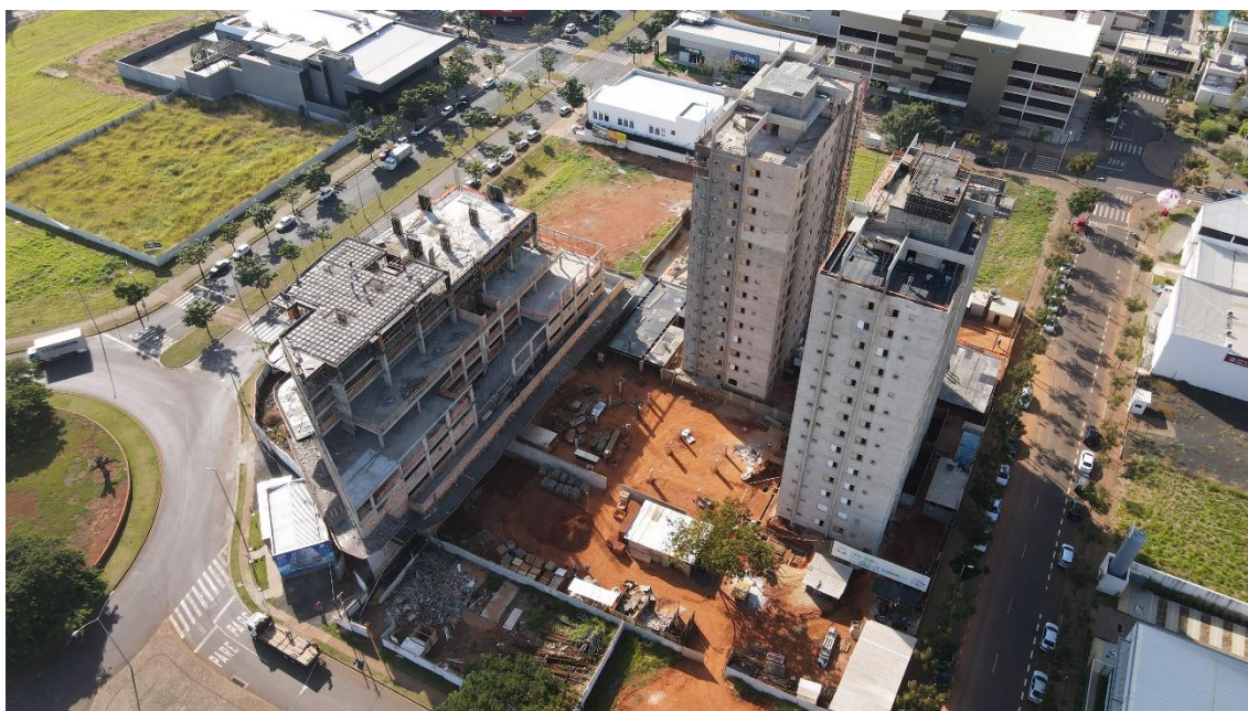
Figura 27: Empreendimentos verticais Granja Marileusa.
