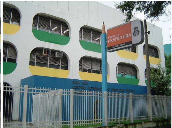
Figura 82 - Fachada do CIEP Tancredo Neves
