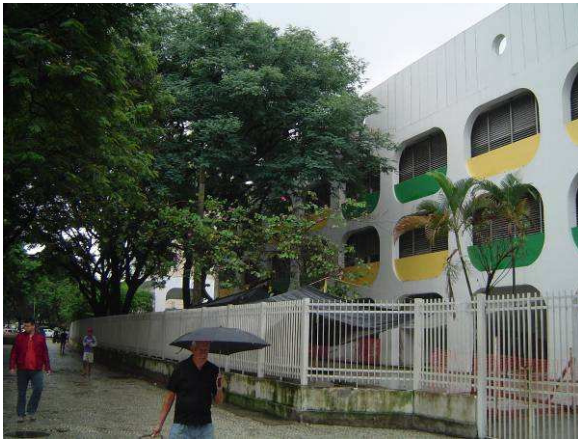
Figura 81 - Fachada do CIEP Tancredo Neves
