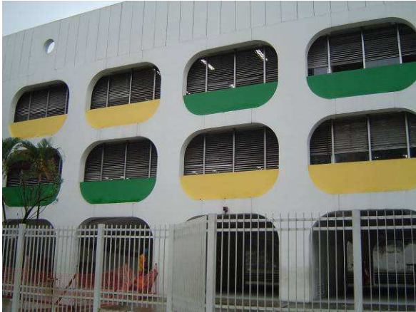
Figura 37 – Detalhe das janelas
