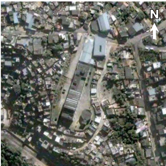
Figura 70 - CIEP Dep. José Carlos de Brandão Monteiro
