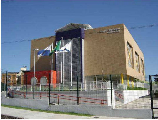
Figura 111 - Vista da EM Colecchio em Bangu
