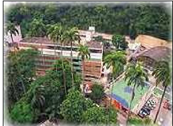
Figura 04 - Vista aérea CSVP
