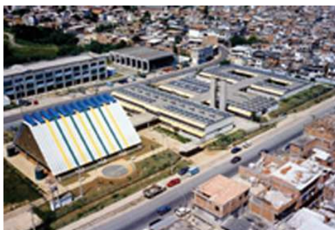
Figura 108 - Vista CIAC Jacarepaguá, RJ. Ao Fundo a presença de um CIEP
