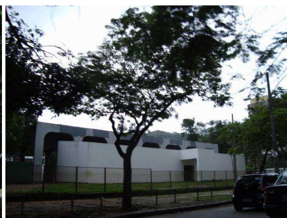
Figura 88 - Vista externa do ginásio esportivo
