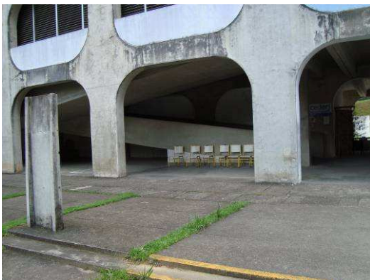
Figura 39 – Detalhe rampa e vão acesso ao pátio
