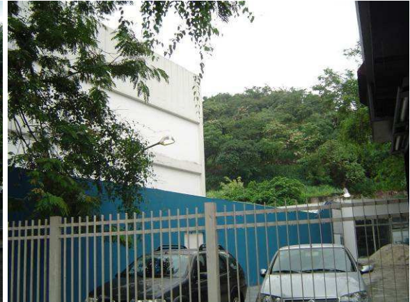
Figura 79 - Lateral do CIEP Tancredo Neves
