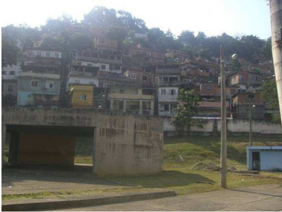
Figura 100 - Vista da biblioteca inacabada com favela ao fundo
