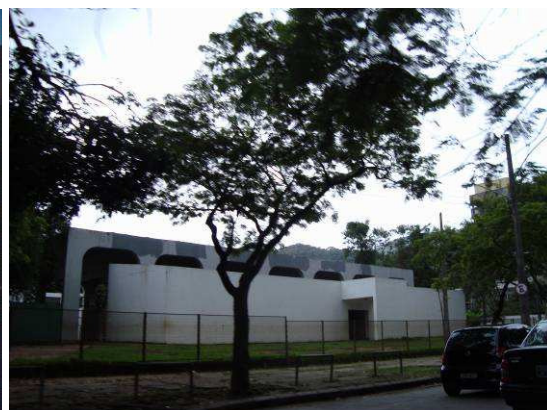
Figura 44 - Vista dos fundos da quadra esportiva
