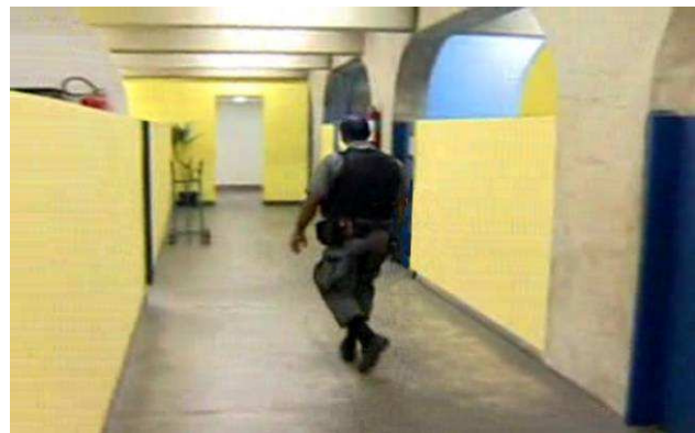
Figura 40 - Corredor da edificação principal
