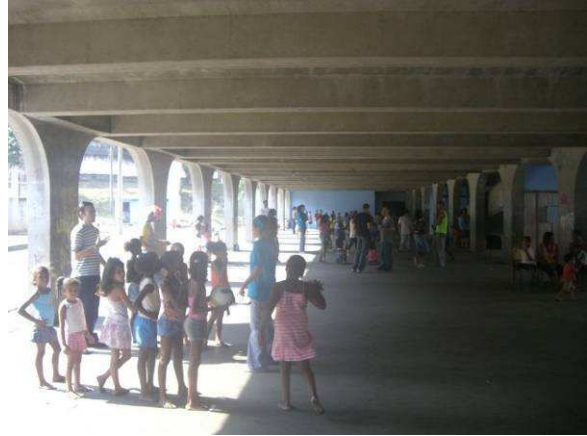
Figura 101 - Pátio sob edificação principal
