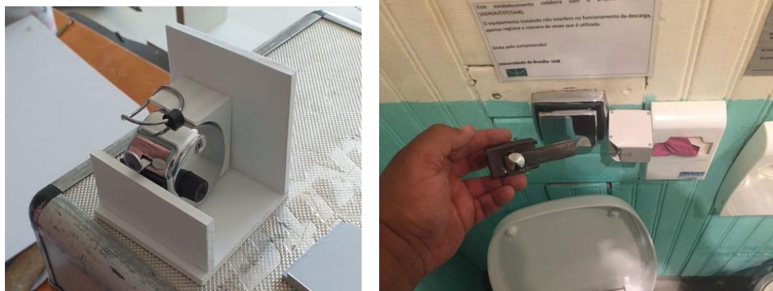
Figura 13 - Primeira foto: produção da peça para encaixe do cronômetro analógico na válvula de descarga. Segunda foto: cronômetro analógico instalado na válvula de descarga do sanitário masculino de clientes do restaurante
