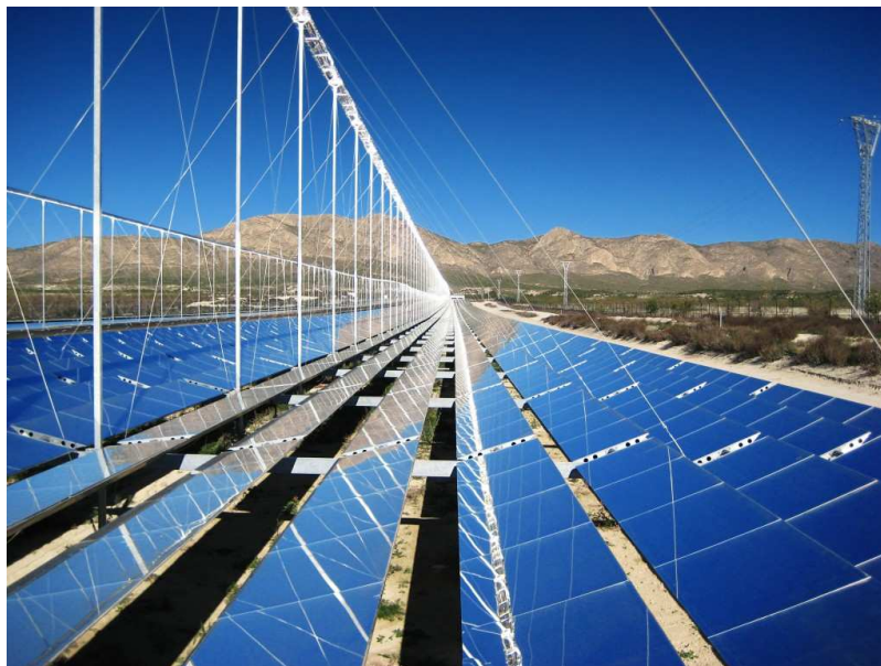
Figura 2.13: Espelho e receptor LFR em Dhursar, na Índia (MICC, 2020)
