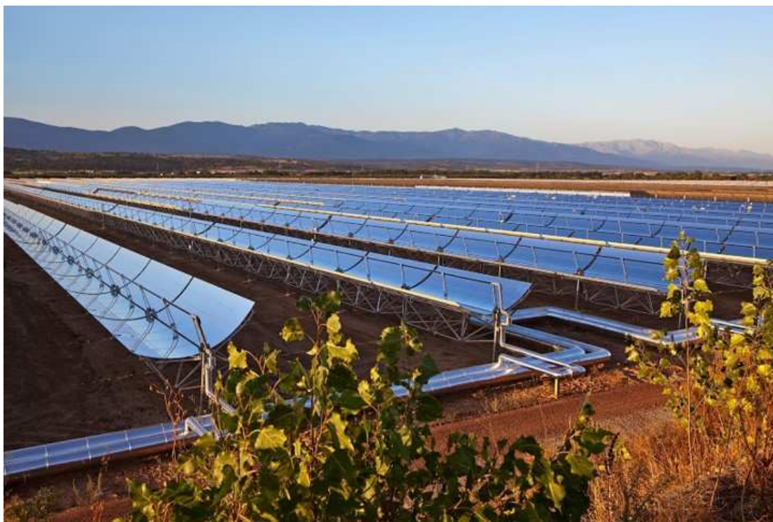
Figura 2.9: Coletores cilíndrico-parabólicos (MICC, 2020)
