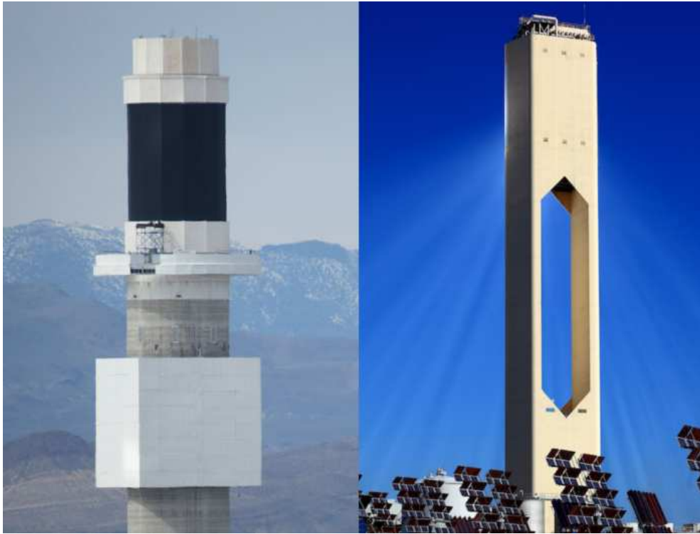
Figura 2.7: Receptor cilíndrico (esquerda) e receptor de cavidade (direita)
