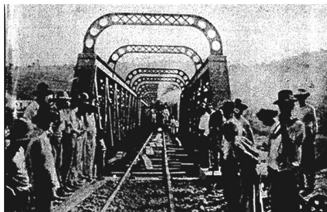
Figura 2: Ponte de Ferro no dia em que trafegou o trem inaugural.
