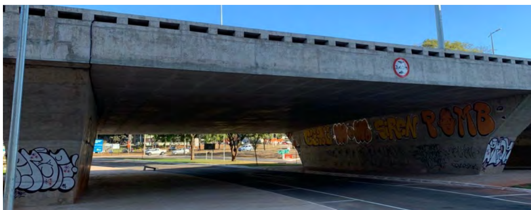
Figura 8. Revitalização urbana da área após Retrofit, Viaduto sobre a Galeria dos Estados, Brasília, DF (Fonte: autoral)
