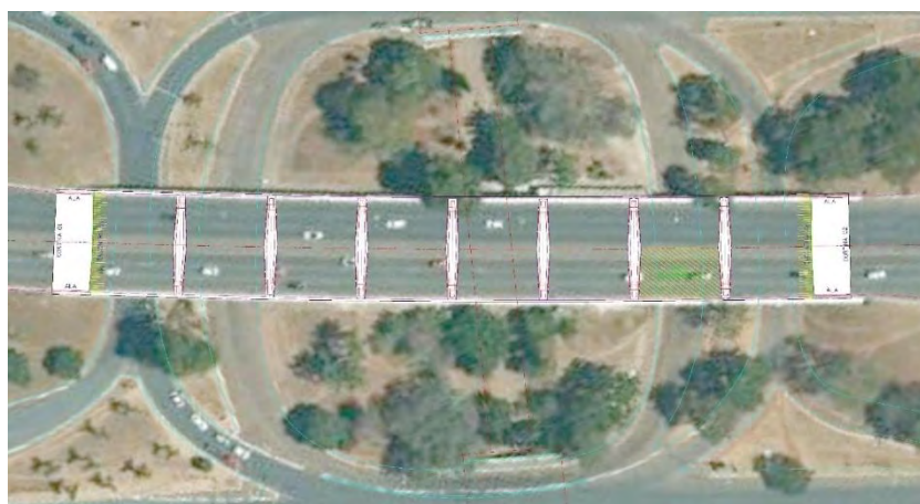
Figura 2: Vista ortogonal das projeções dos pilares do viaduto.
