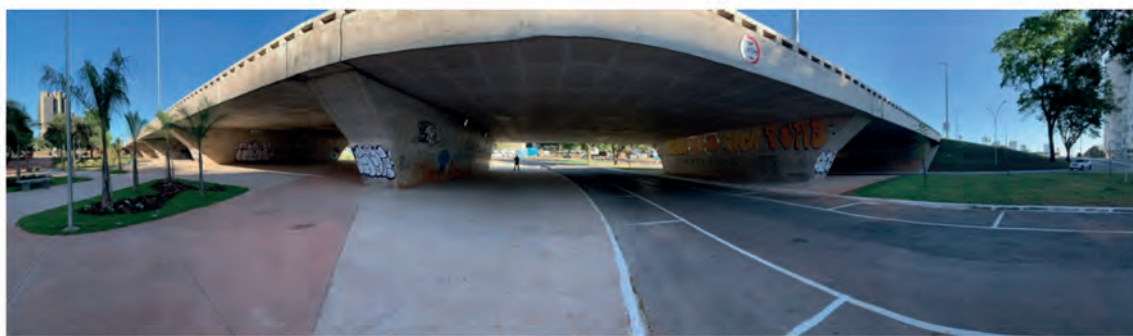
Figura 11. Vista leste da revitalização urbana da área após Retrofit, Viaduto sobre a Galeria dos Estados, Brasília, DF (Fonte: autoral)
