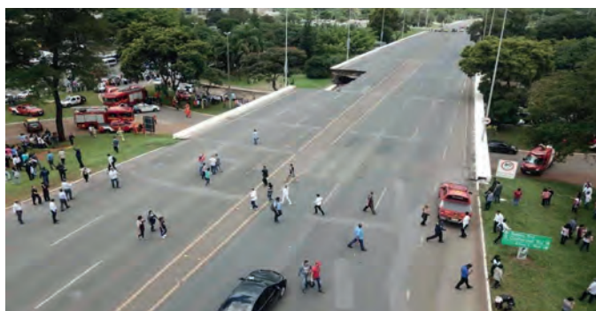
Figura 8: Vista do local onde o tabuleiro precipitou-se.
