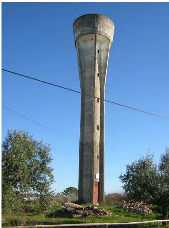
Figura 5. Fotografia do reservatório elevado de água
