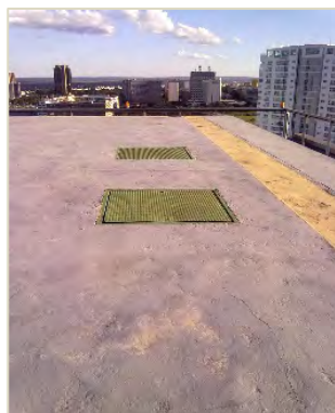
Figura 10 – Alçapões das caixas d’água
