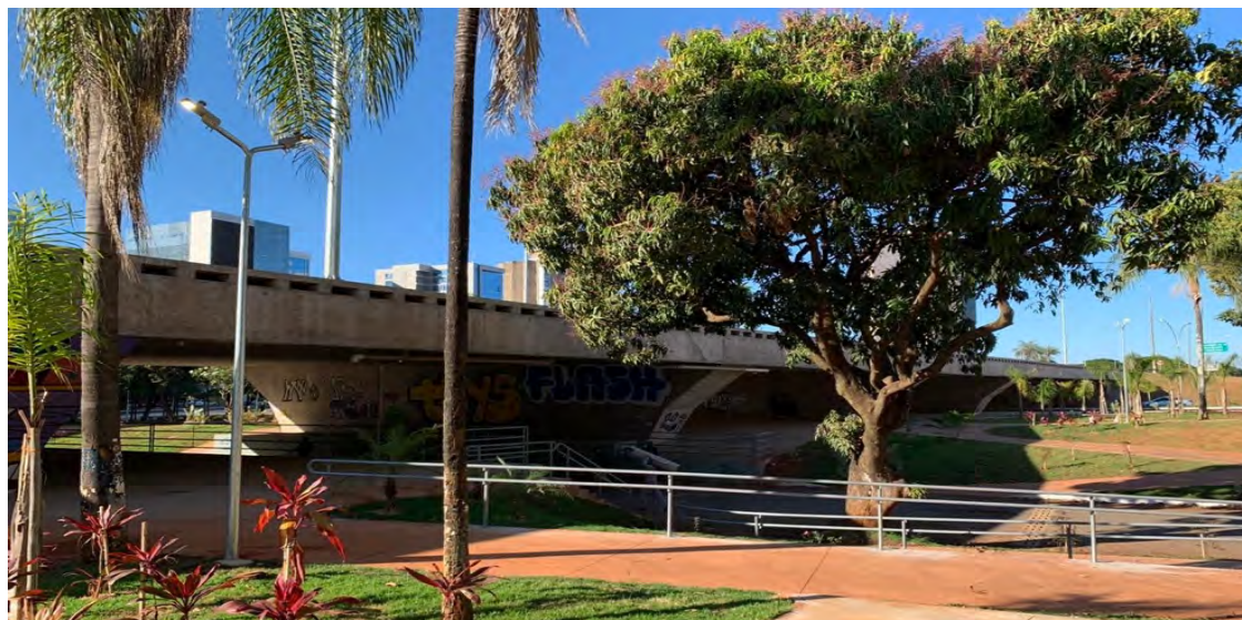
Figura 4. Pilares em formato “asa delta”, Viaduto sobre a Galeria dos Estados, Brasília, DF (Fonte: autoral)
