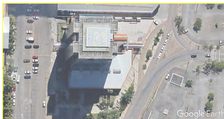
Figura 6 – Vista aérea da PDC vistoriada. Imagem: Google Earth
