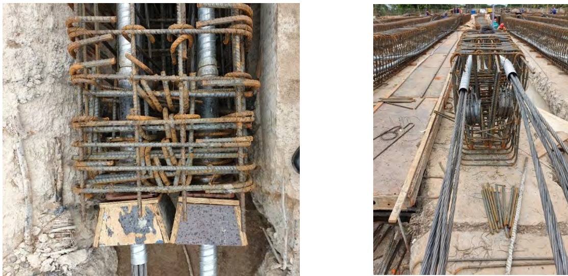
Figura 13: Encabeçamento e tensores das vigas das lajes.
