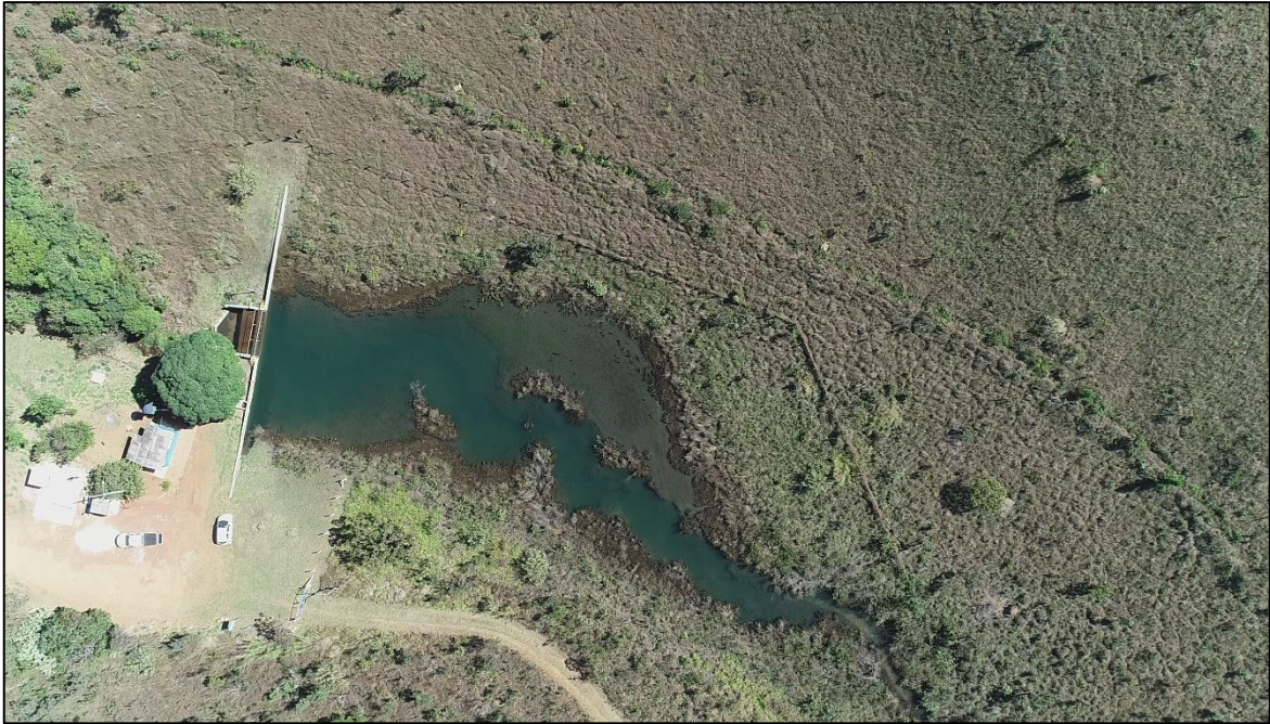
Figura 25 – Imagem aérea da captação do Capão da Onça Fonte: Adasa (2019a)
