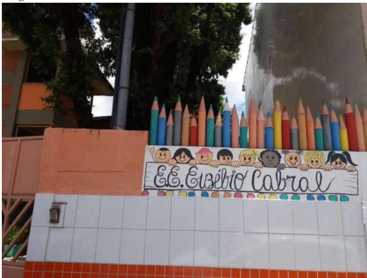
Imagem 3. Fachada da Escola Estadual Euzébio Cabral
