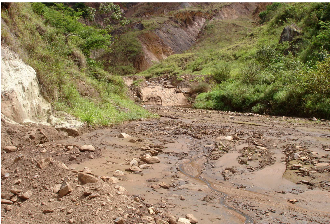
Foto 09: Diques rompidos e assoreamento dos vales na mina Esperança.
