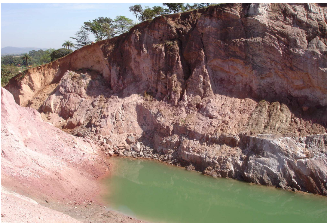
Foto 50: Outro trecho da lavra da Aglofilito, notando-se taludes com inclinação negativa e, à esquerda, deslizamento de material.
