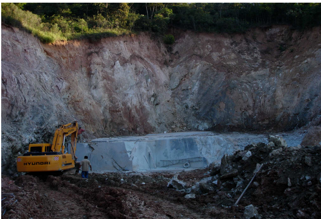
Foto 46: Mina da Cava Brasil. Note-se equipamento moderno e ausência de banqueamento no material estéril superposto à rocha de pedra-sabão.
