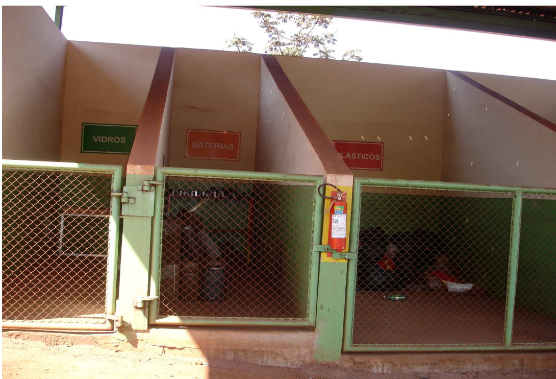
Foto 12: Galpão de armazenamento de material coletado seletivamente para reciclagem, na mina Lagoa das Flores.
