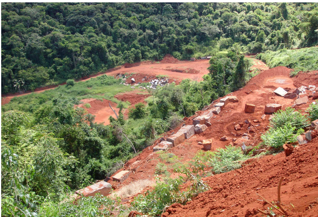
Foto 47: Mina de granito ornamental da Granasa, em São Pedro dos Ferros. Note-se melhor organização da lavra e medidas de controle ambiental.
