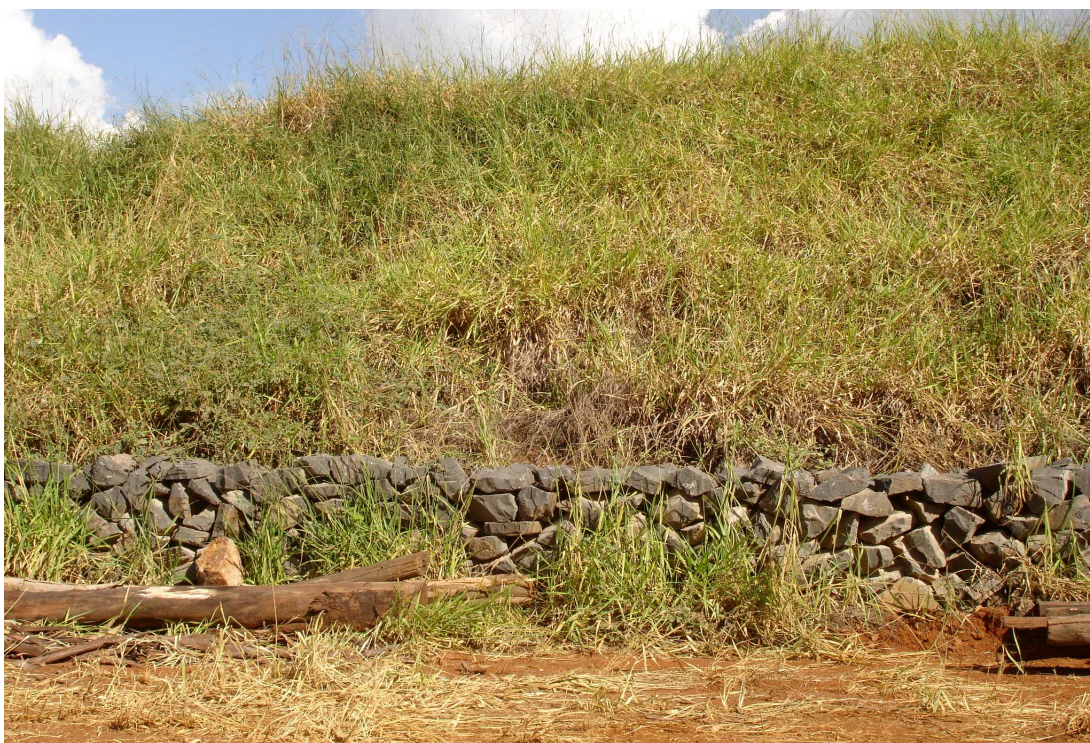
Foto 26: Talude da estrada da britagem na mina de calcário da Ducal, já revegetado com capim e protegido com mureta de pé.
