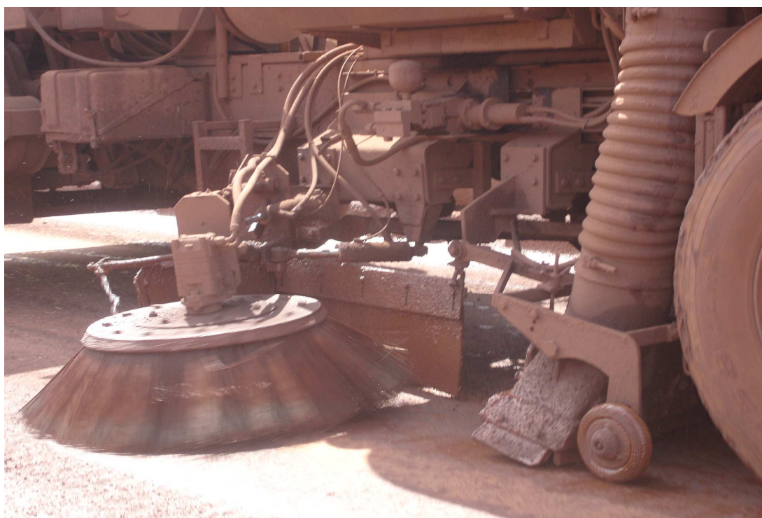
Foto 04: Limpeza da estrada que liga a mina de Capão Xavier à instalação de beneficiamento na mina da Mutuca.
