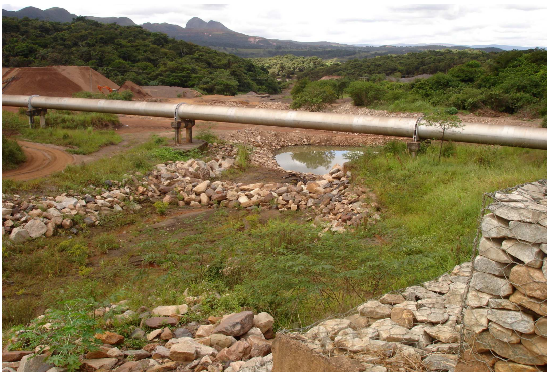
Foto 10: Adutora da Copasa, logo a jusante do dique de gabião, na parte mais baixa da mina Esperança. Junto à mata, à esquerda, corre o rio Paraopeba, que teve um trecho de seu leito assoreado por sedimentos advindos da mina.
