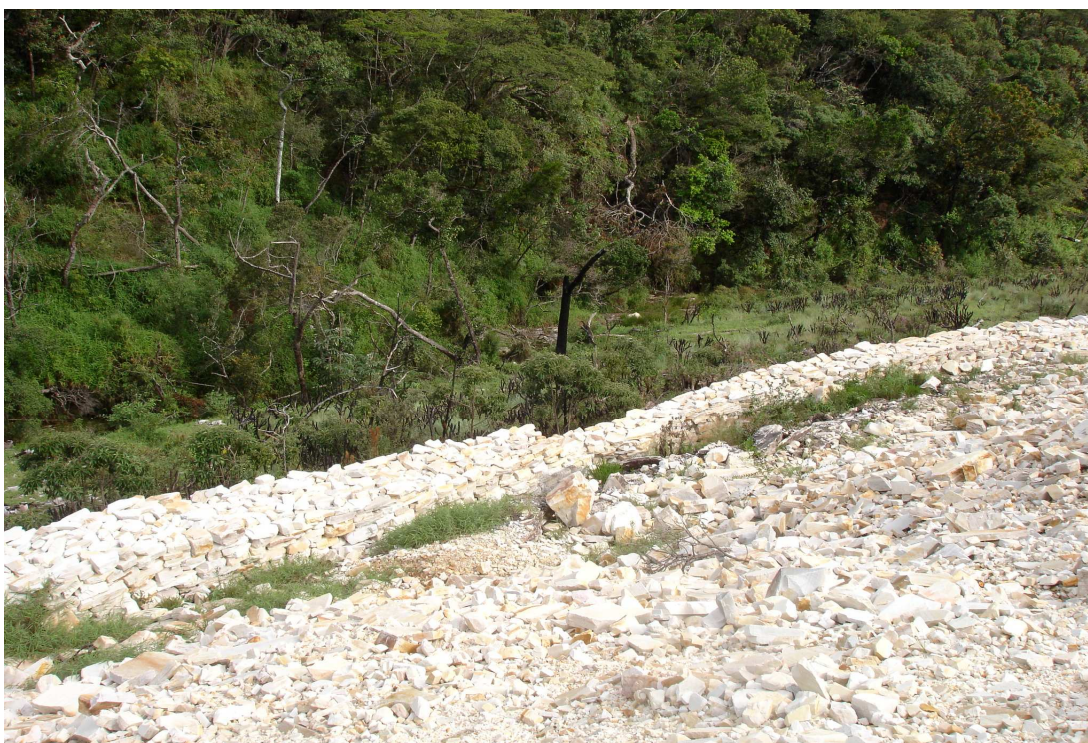
Foto 32: Mureta de contenção ao pé da pilha de estéril e rejeito na mina da A. Pelúcio, isolando-a da área de preservação permanente.
