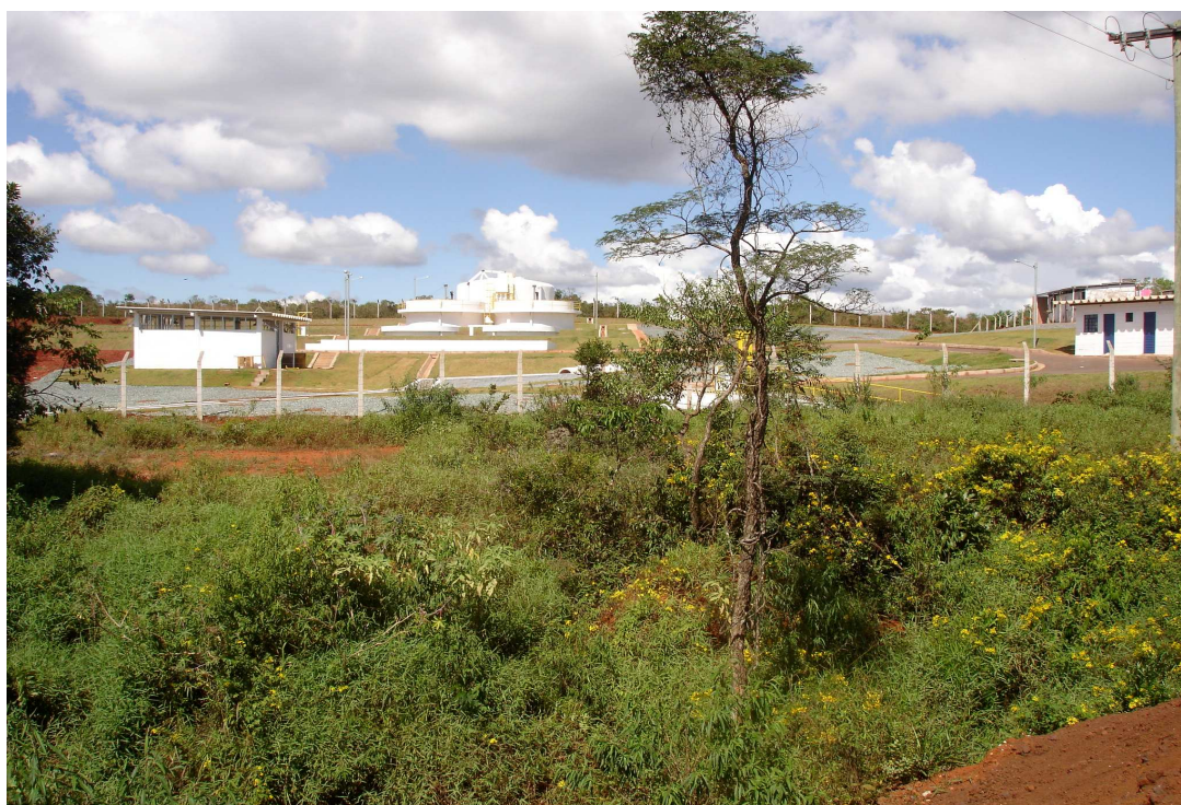
Foto 06: Estação de tratamento de esgoto construída em área doada pela MBR, como uma das medidas compensatórias da mina de Capão Xavier.
