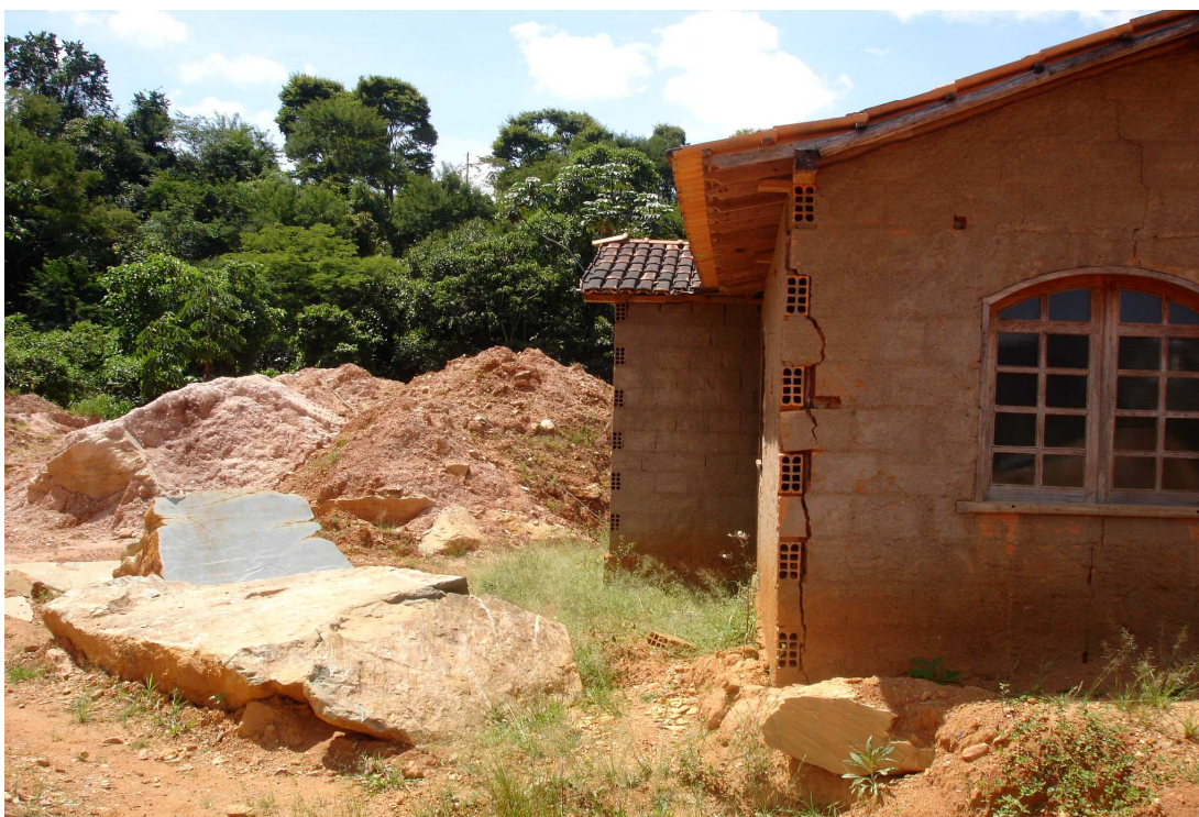
Foto 40: Lavra de pedra-sabão, clandestina e abandonada, da MSM Soapstone. Observe-se trinca provocada em residência situada muito próxima à cava.
