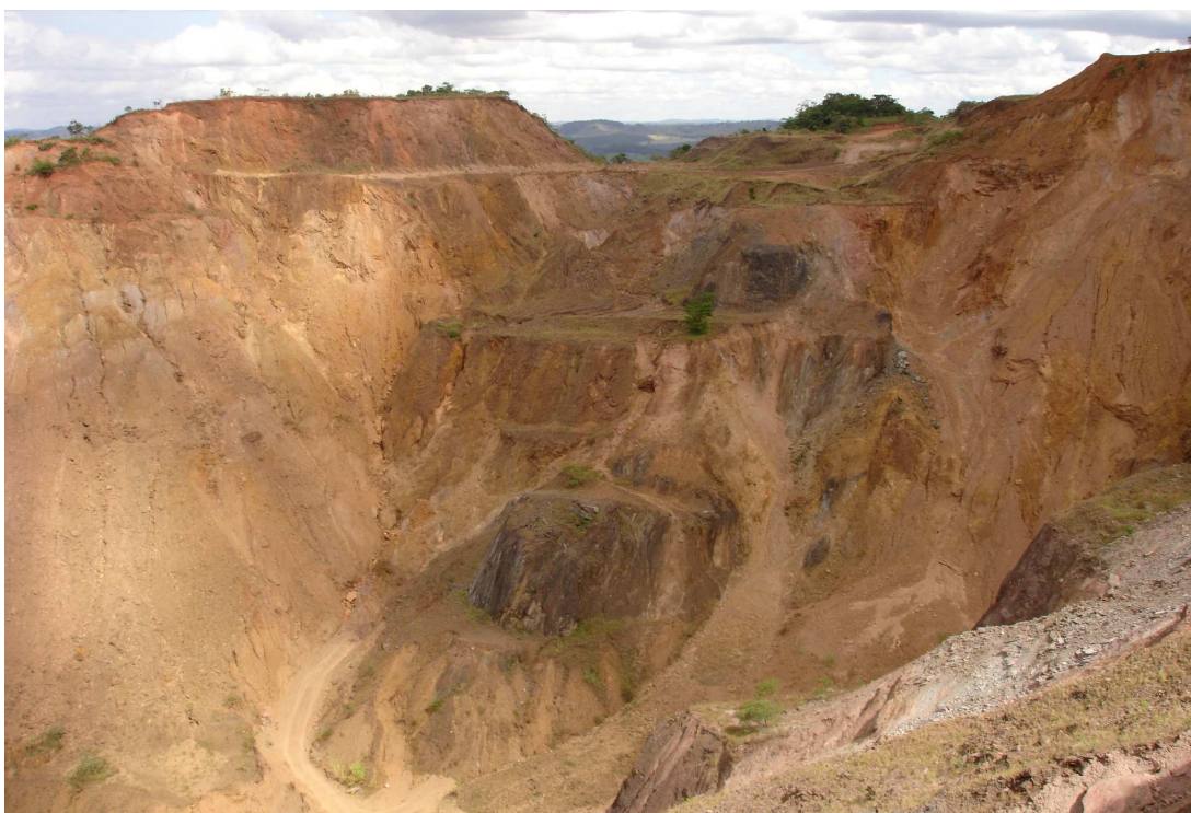
Foto 08: Ausência de bancadas e taludes instáveis na mina Esperança.
