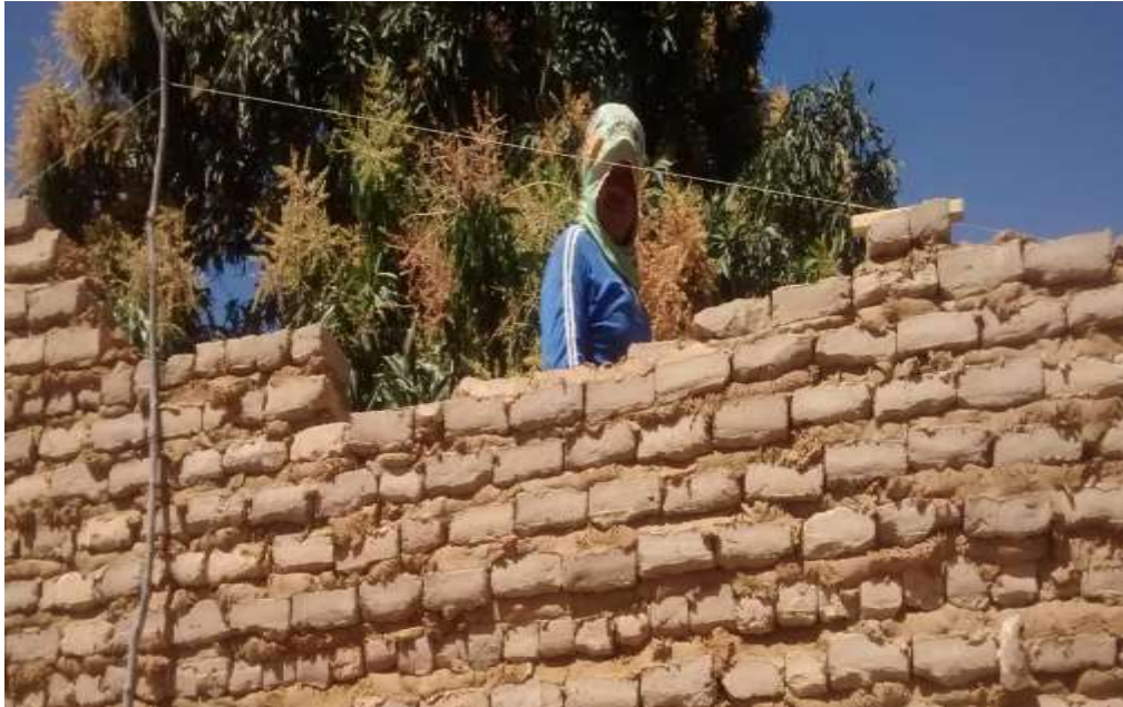
Foto 7 - Atividades de Construção de Casas de Tijolo Cru no Quilombo Arruda
