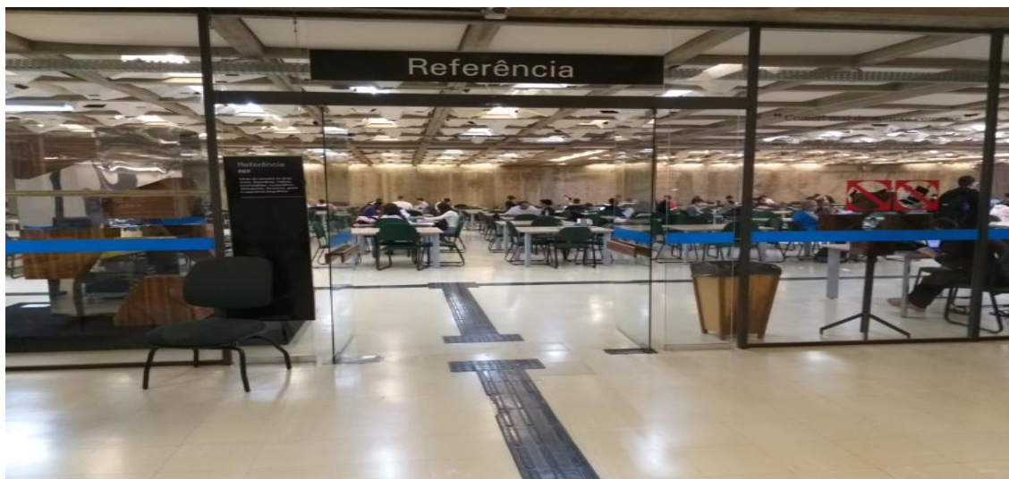
Figura 7 – Fotografia do piso tátil após a chegada à porta da sala de referência
