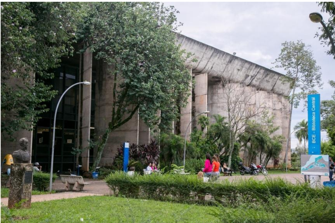
Figura 3 – Fotografia da entrada da Biblioteca Central da UnB
