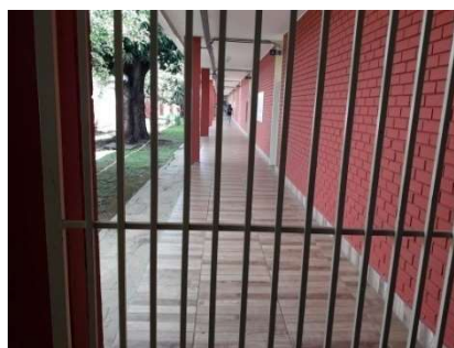
Fig. 2- Grades fechadas no pavilhão inteiro.
