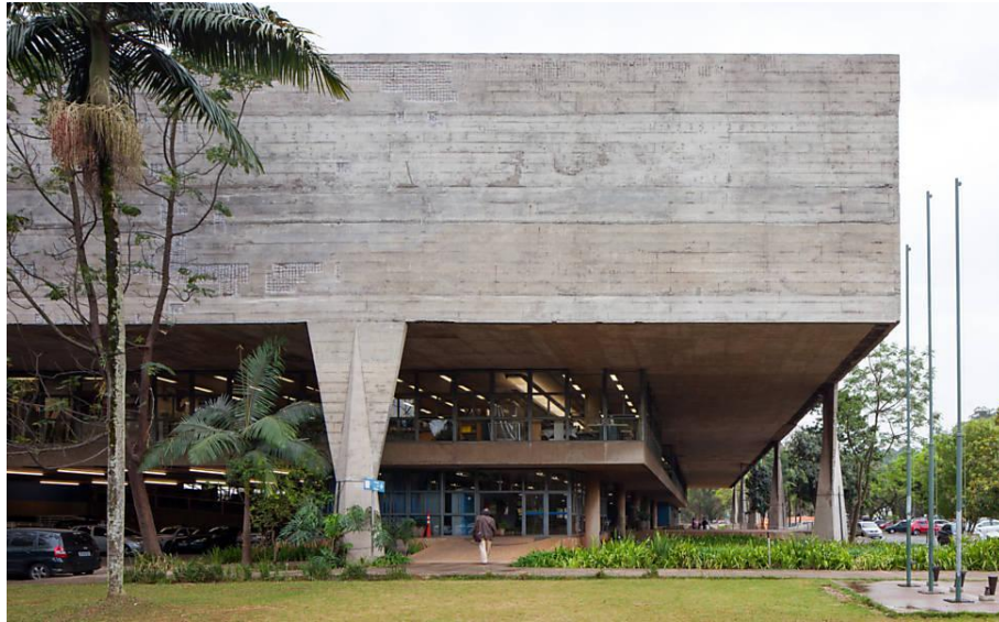
Figura 2: Vista externa da empena lateral do edifício Vilanova Artigas.
