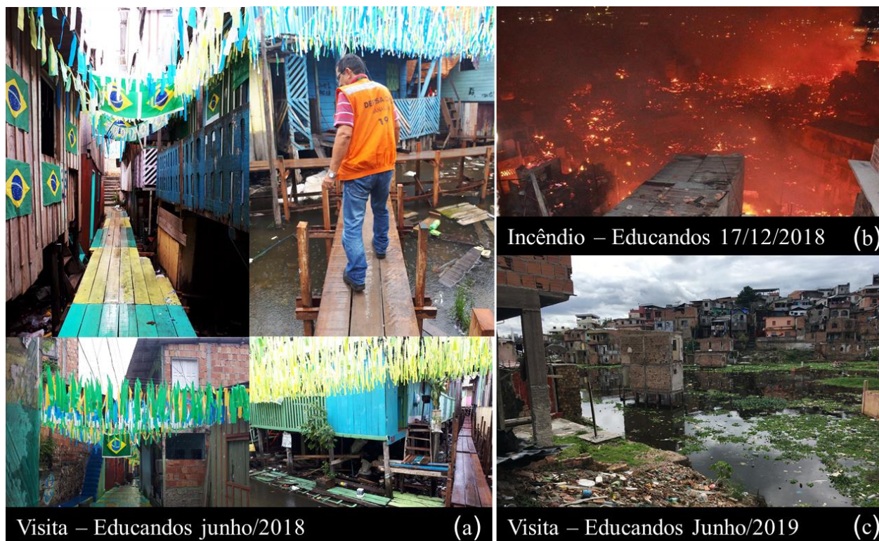
Figura 25. Bairro Educando, Manaus, antes e depois do incêndio de dezembro/2018.
