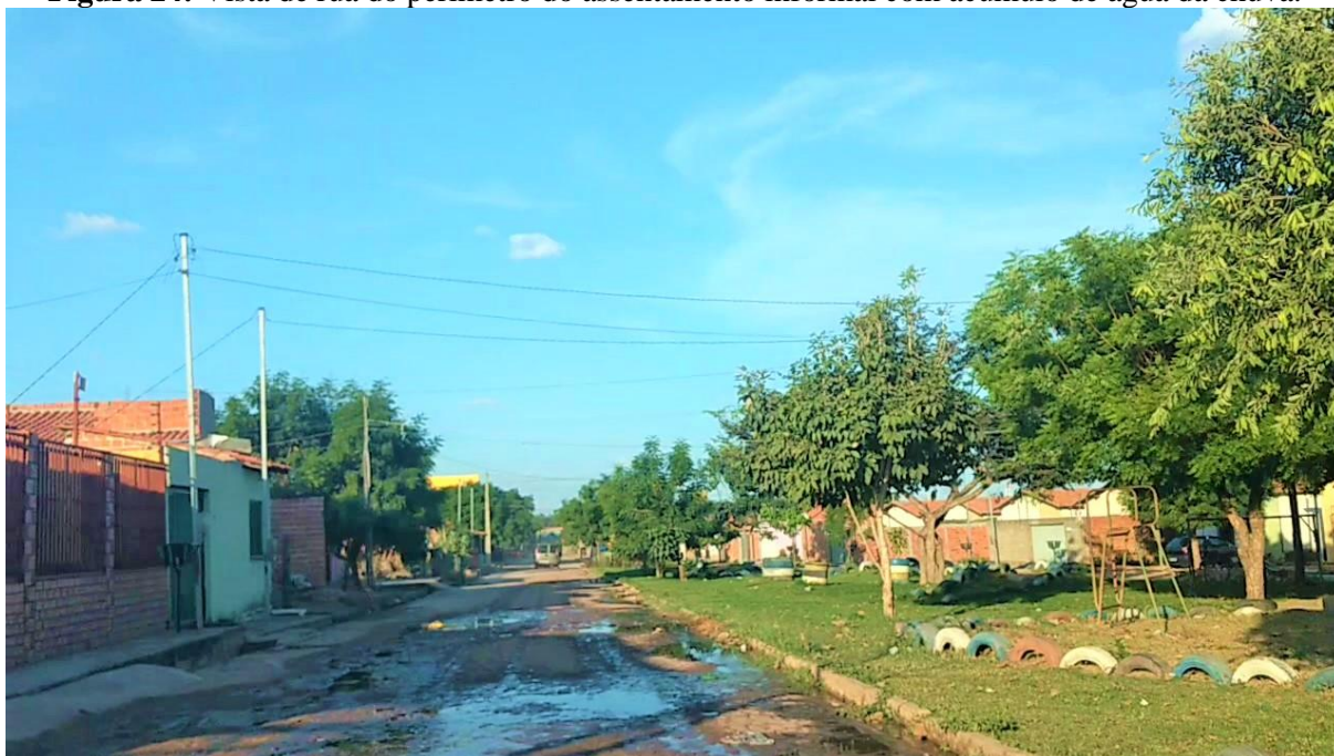
Figura 24: Vista de rua do perímetro do assentamento informal com acúmulo de água da chuva.
