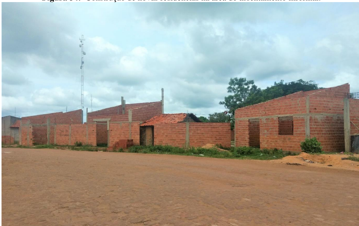
Figura 34: Construção de novas residências na área do assentamento informal.
