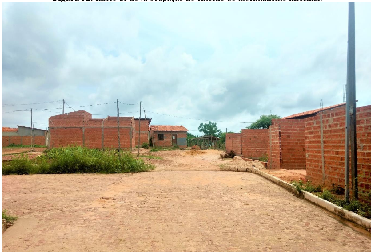
Figura 51: Início de nova ocupação no entorno do assentamento informal.
