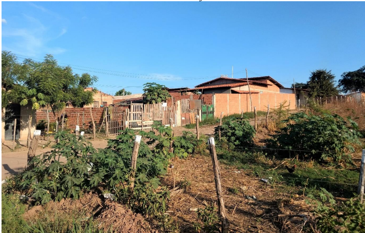
Figura 33: Residências do assentamento informal com estrutura de materiais diversos. Da esquerda ao centro da foto: residência em alvenaria de tijolos, com cerca de madeira e arame farpado; residência com muro improvisado com pedaços de madeira emparelhados; e residência com estrutura e muro em alvenaria de tijolos.
