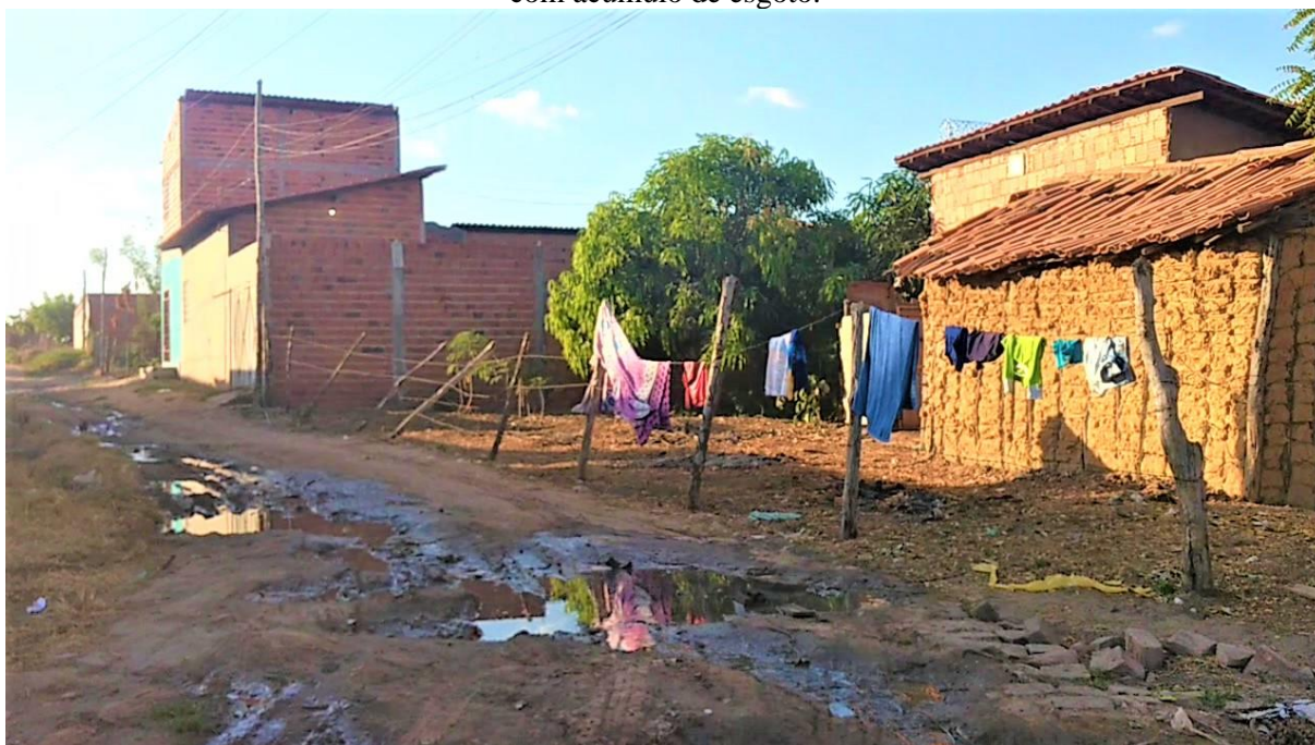
Figura 25: Vista de rua interna ao assentamento informal com superfície irregular, sem calçamento e com acúmulo de esgoto.
