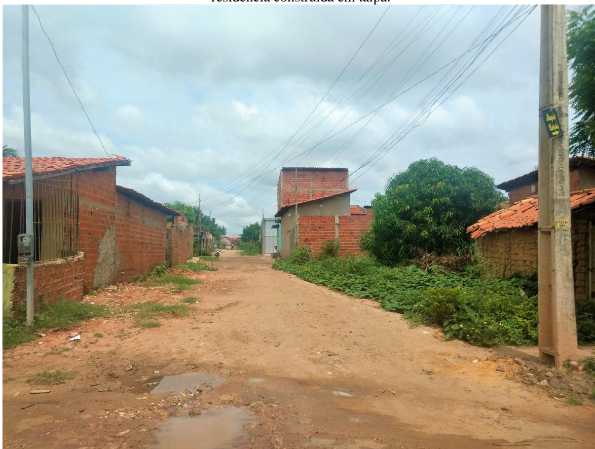
Figura 32: Residências do assentamento informal. Pode-se ver as diferentes soluções estruturais. Ao centro da foto, residência de dois pavimentos com estrutura em alvenaria de tijolos; à direita, residência construída em taipa.
