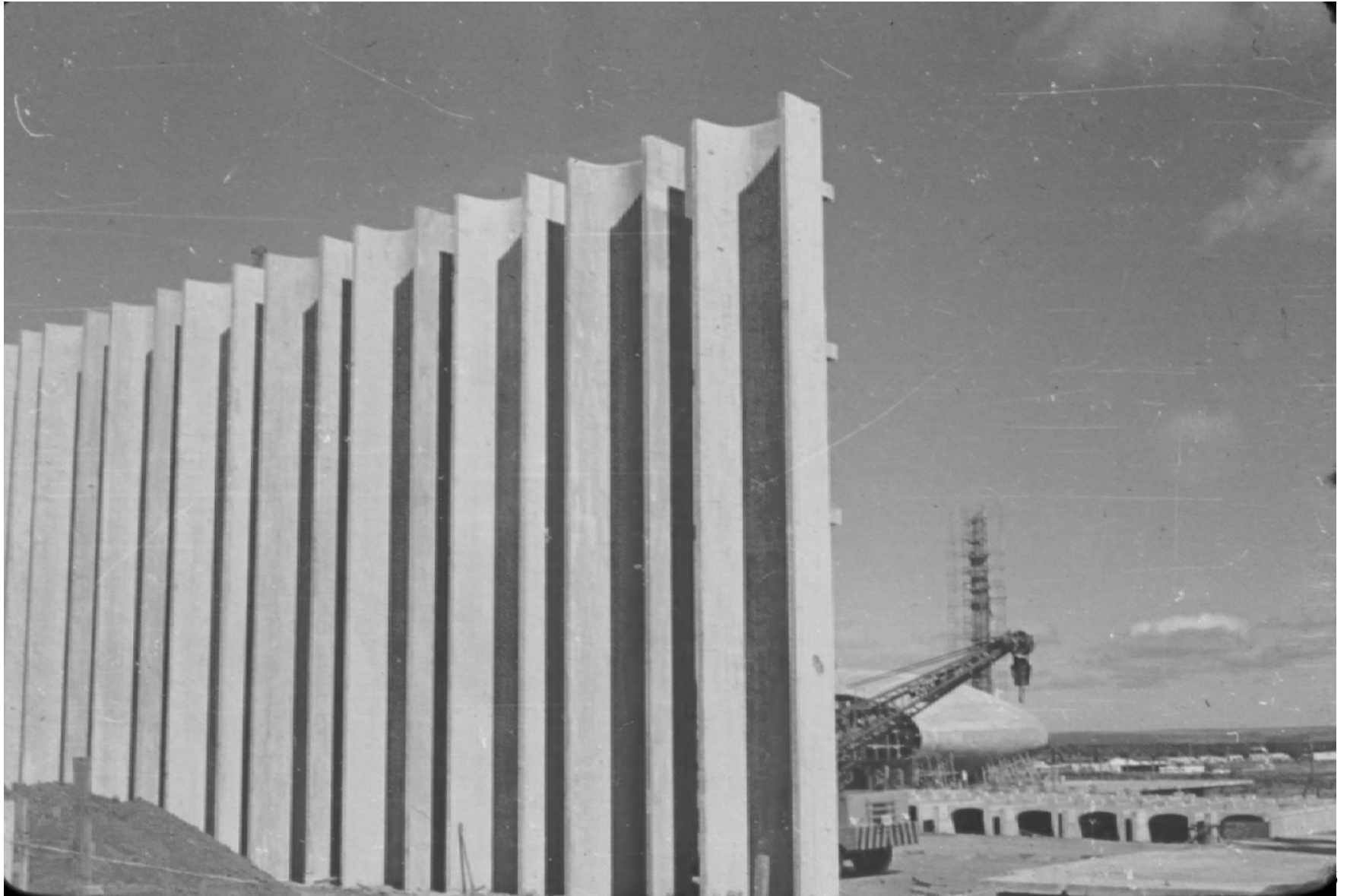
Figura 43: Montagem dos pilares. Fonte: Arquivo da CRO11.
