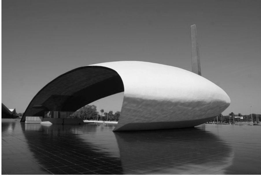
Figura 24: Casca em Concreto Armado. Fonte: Acervo do Autor.
