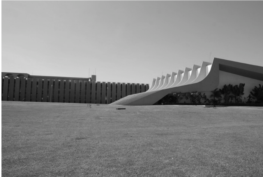
Figura 32: Relação entre as estruturas das edificações. Fonte: Acervo do Autor
