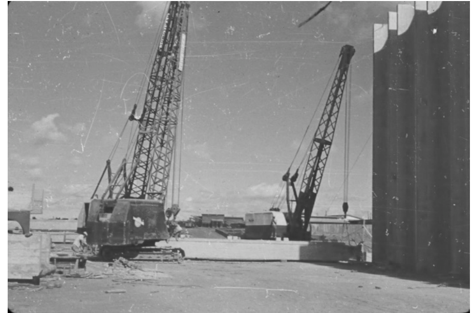
Figura 42: Guindastes para movimentação dos pilares. Fonte: Arquivo da CRO11.
