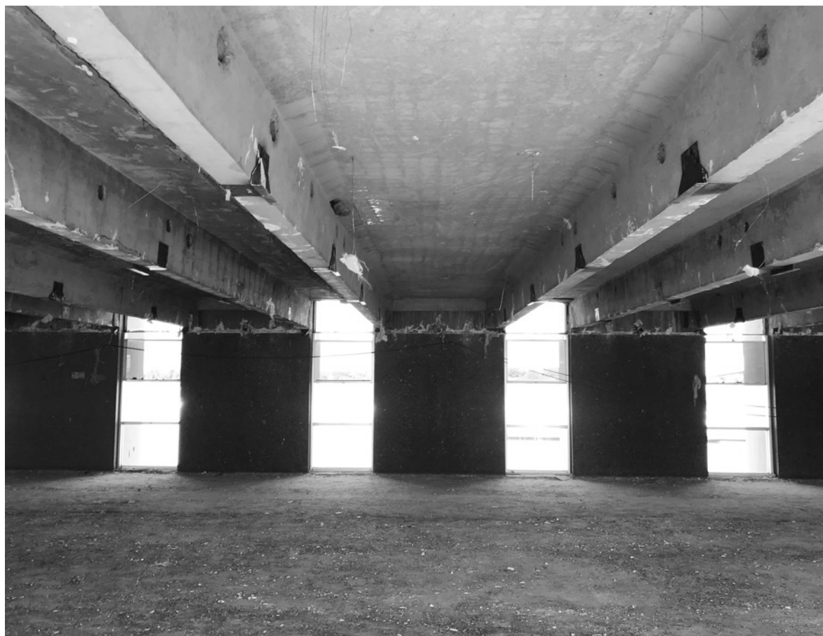
Figura 38: Vista Interna da estrutura do Bloco dos Generais e junção da viga com o pilar. Fonte: Acervo do Autor
