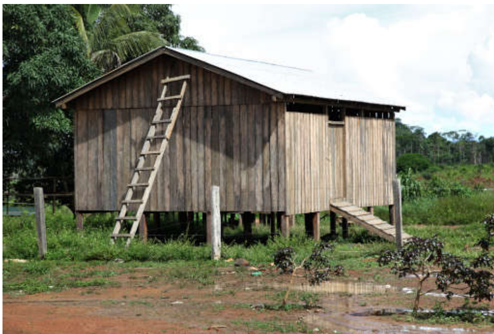
Foto 49: Barracão de armazenamento de castanha. Benfeitoria do Projeto Sulam Indígena.)
