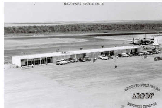
[f.134] Primeiro Terminal aeroportuário de Brasília projetado por Oscar Niemeyer de caráter provisório. Fonte: Arquivo público do Distrito Federal.
