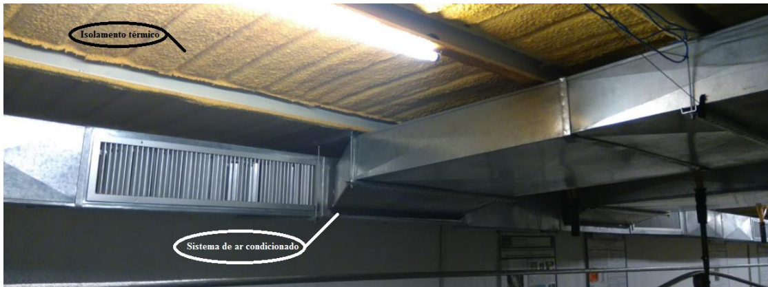
Figura 4.7 - Sistema de ar condicionado e isolamento térmico.
