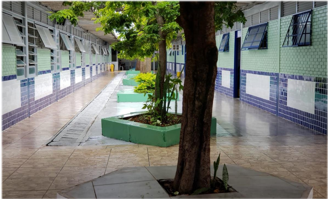
Figura 6: Estrutura Interna corredor de acesso a salas de aulas. Fonte: Da autora (2019).
