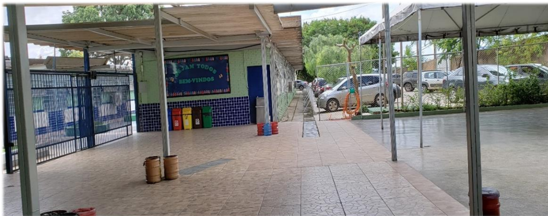
Figura 4: Estrutura Interna saguão da entrada do CEF03. Fonte: Da autora (2019).
