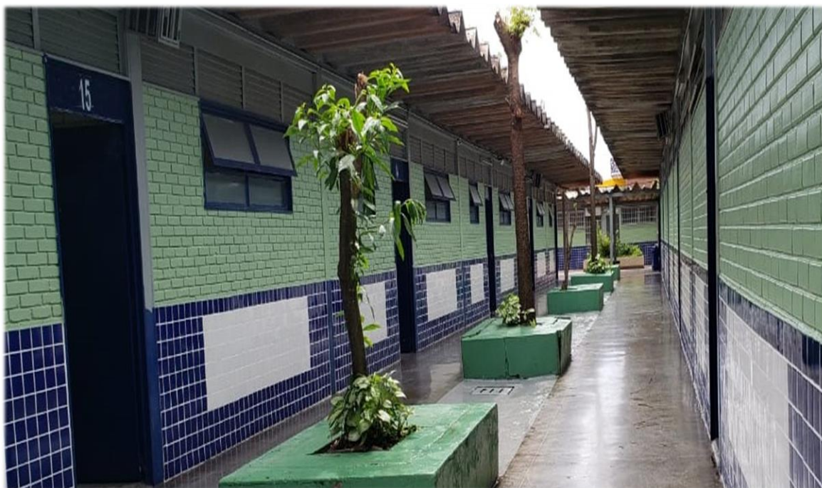
Figura 5: Estrutura Interna corredor de acesso a salas de aulas. Fonte: Da autora (2019).
