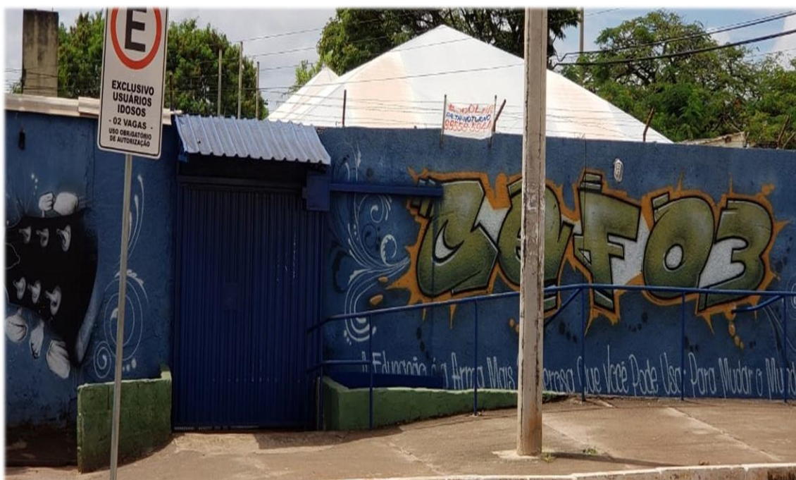
Figura 3: Fachada Externa do CEF03. Fonte: O autor (2019).
