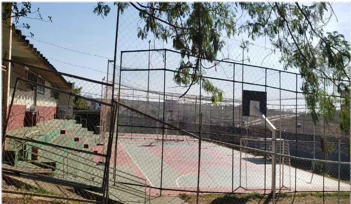
Figura 11: Estrutura Interna quadra de esportes. Fonte: Da autora (2019).
