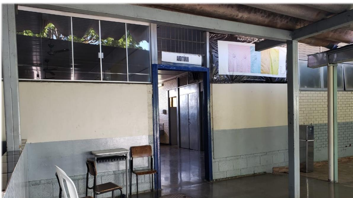
Figura 9: Estrutura Interna acesso ao auditório e banheiros. Fonte: Da autora (2019).
