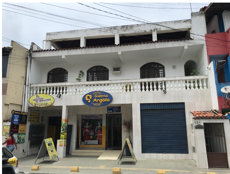
Figura 56. Imóvel com uso residencial, comercial e de serviços com acessos independentes, na Rua Simões Filho, Boca do Rio.
