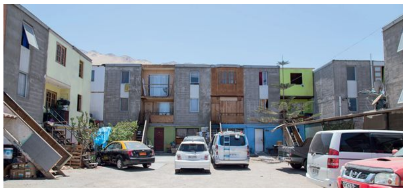
Figura 13. Ambiente externo após intervenção dos moradores em Quinta Monroy, Chile. Fonte: Arquitechne. Acesso em 7 de dezembro de 2019
