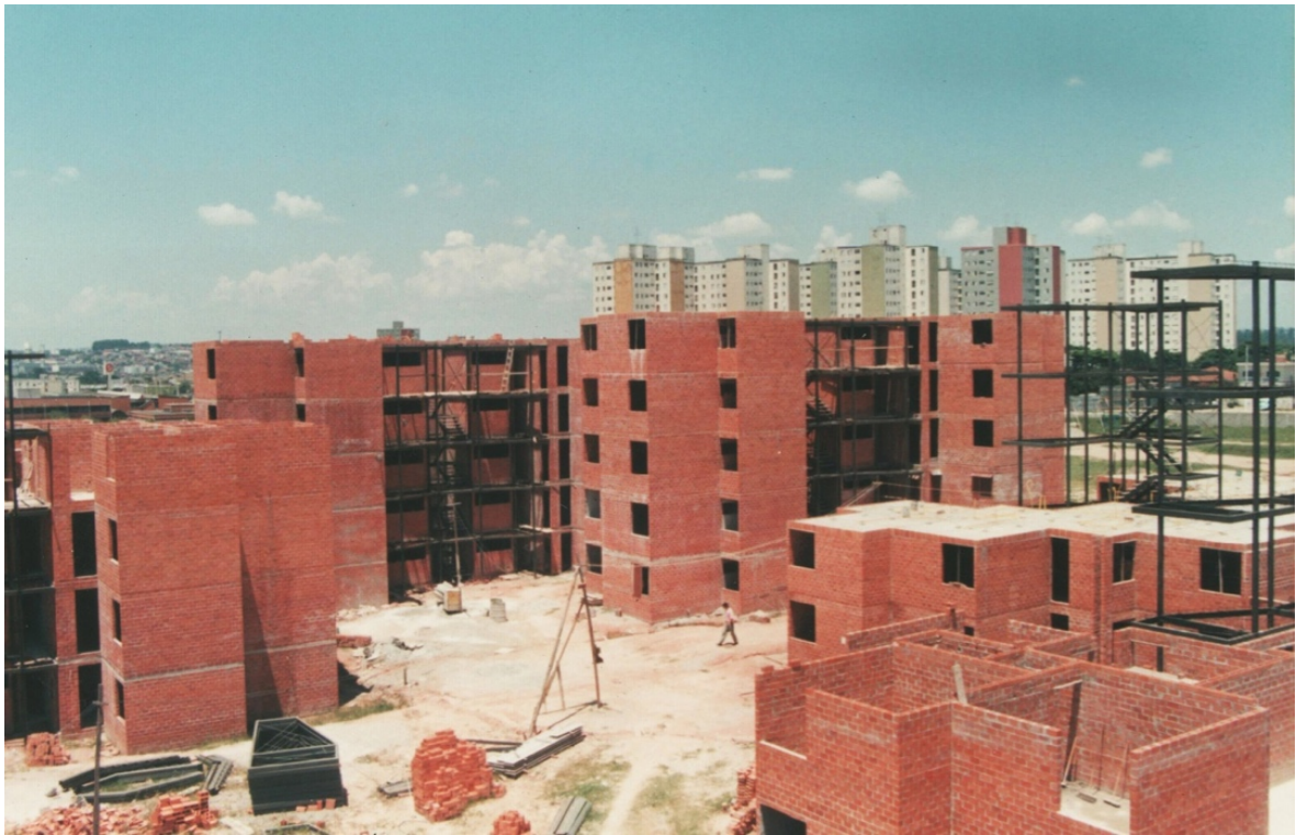
Figura 15. Obras em andamento no COPROMO em OSASCO, SP. Fonte: USINA CTAH. Acesso em 6 de dezembro de 2019.
