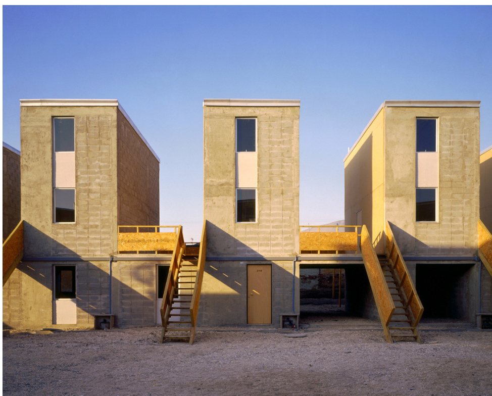
Figura 12. Unidades entregue aos moradores em Quinta Monroy, Chile. Foto: Cristóbal Palma. Retirado de archdaily.com, acesso em 7 de dezembro de 2019
