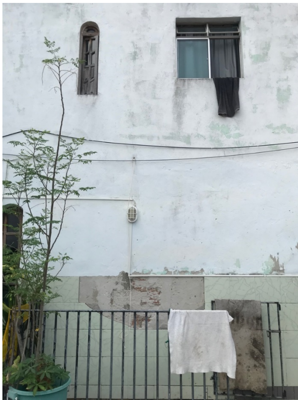
Figura 46. Fachada lateral da Casa 27, na Rua Hermínio Gonçalves. Diferenças das esquadrias marcam os períodos das adaptações realizadas pelos moradores. Fonte: Foto do autor, 2020.
