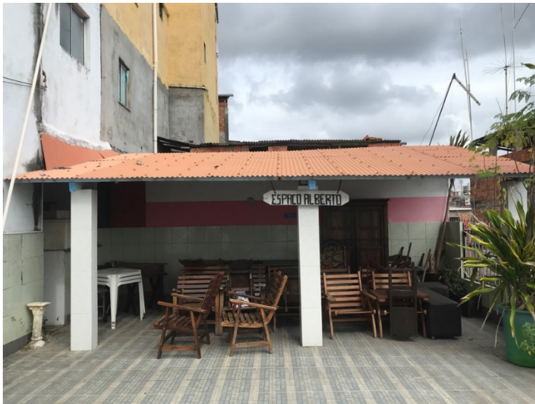
Figura 44. Ampliação com área de lazer. Fonte: Foto do autor, 2020.
