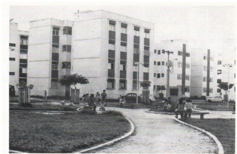
Figura 5. Edificações com elementos repetitivos no Conjunto Jones Santos Neves, em Vitória, ES.
