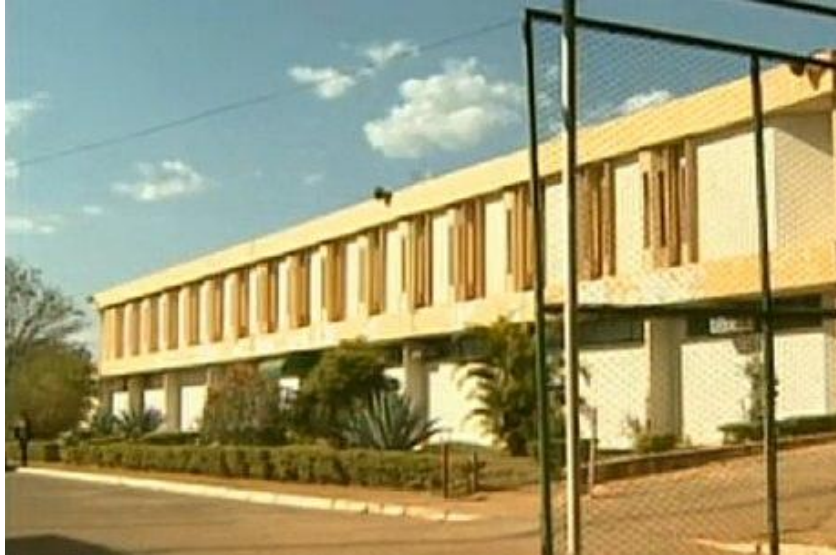
Figura 6 - Prédio da administração da PFDF
