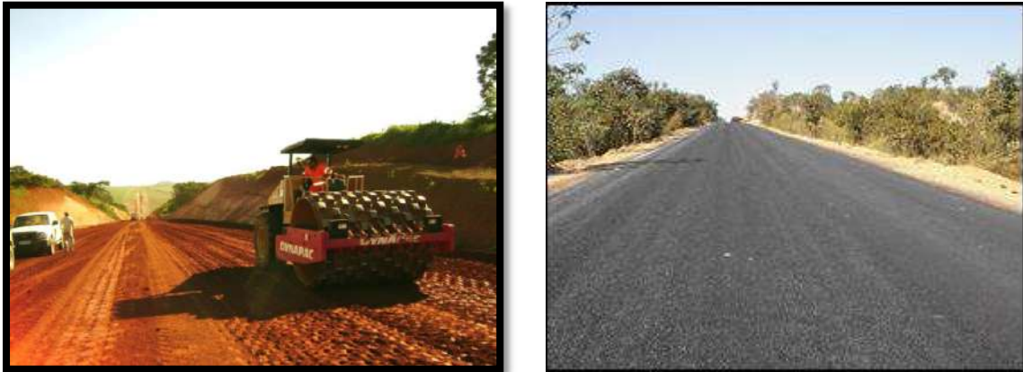
Foto 09 e 10: pavimentação da BR 317 (RIMA/DNIT, 2008)
