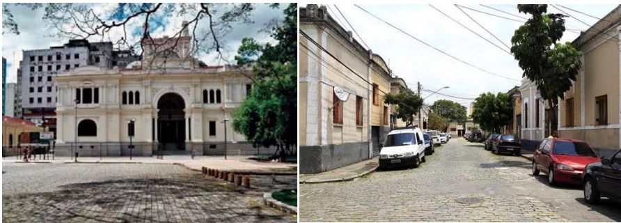
Imagem 24: Prédio do Ponto Chic antes do restauro, Jardim da Luz, s.d., São Paulo/SP, Foto de Mônica Zarattini (Fonte: Acervo Iphan). Imagem 25: Edifício Ramos de Azevedo após o restauro, s.d., São Paulo/SP (Fonte: Acervo SCM/PMSP). Imagem 26: Vila Economizadora, s.d., São Paulo/SP, foto Milena Leonel (Fonte: Acervo Refúgios Urbanos).
