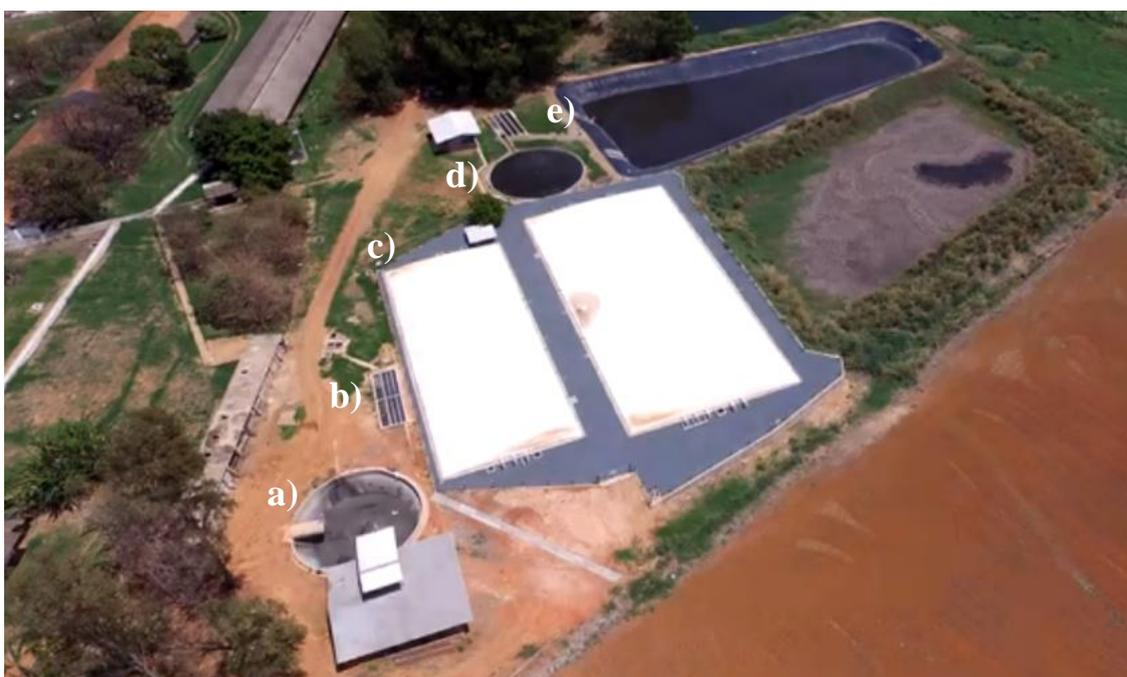
**Figura 1** - Unidade de tratamento de dejetos de suínos da Fazenda Miunça. a) Tanque primário de recebimento e homogeneização do dejetos bruto. b) Tanque de decantação. c) Câmaras de biodigestão. d) Lagoa de maturação. e) Lagoa de armazenamento do efluente tratado.
