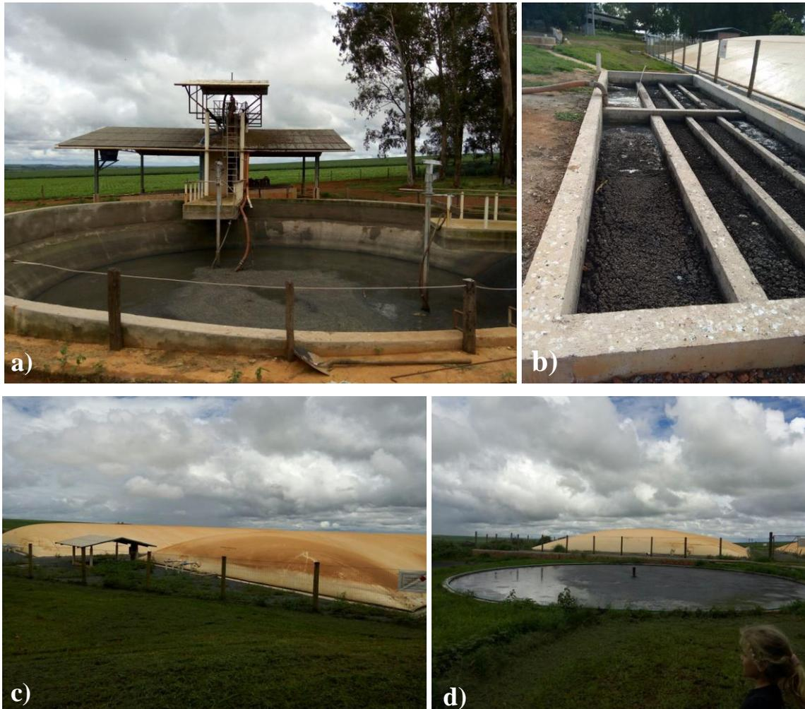
**Figura 2** - Etapas do tratamento de dejetos de suínos em biodigestor na Fazenda Miunça: (a) Tanque primário de recebimento e homogeneização do dejetos bruto. (b) Tanque de decantação. (c) Câmaras de biodigestão. (d): Lagoa de maturação. Foto: Alessandra Monteiro de Paula
