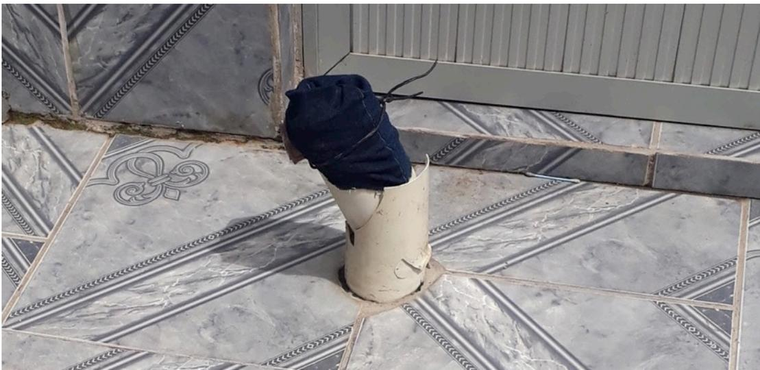
**Figura 60: Gambiarra Teimosense 08 - Retalho de tecido protegendo tubulação.**
