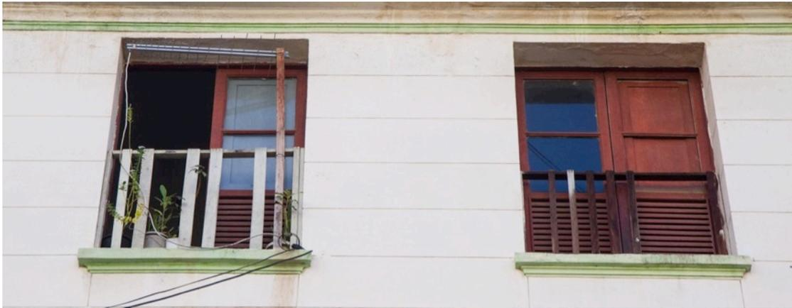
**Figura 47: Gambiarra Carioca 13 - Grade de ripas; uma estendida para suportar a antena.**
