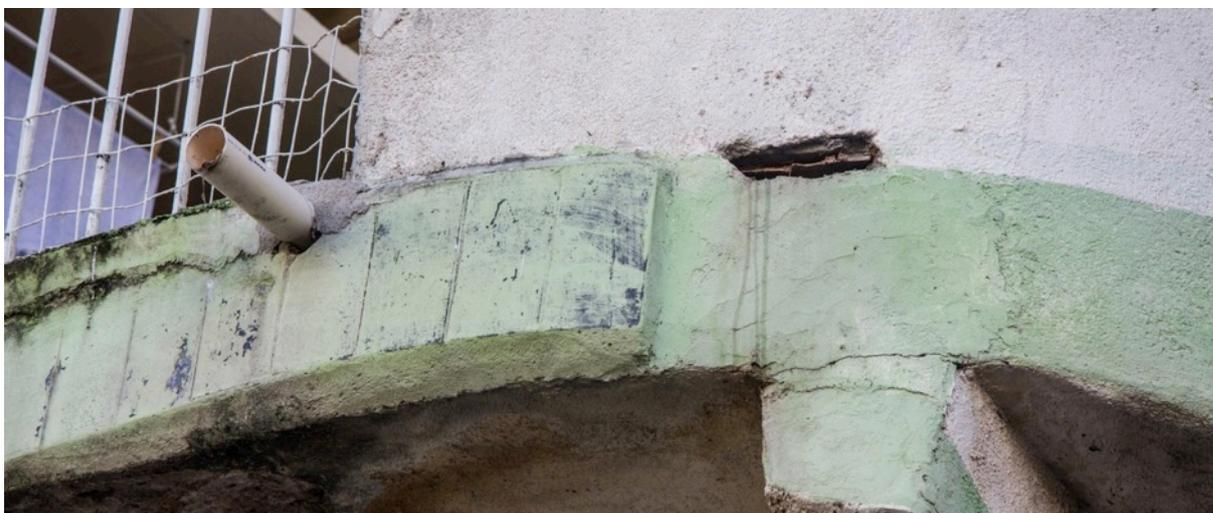
**Figura 44: Gambiarra Carioca 12 - "Puxadinho" denunciado pelo revestimento.**
