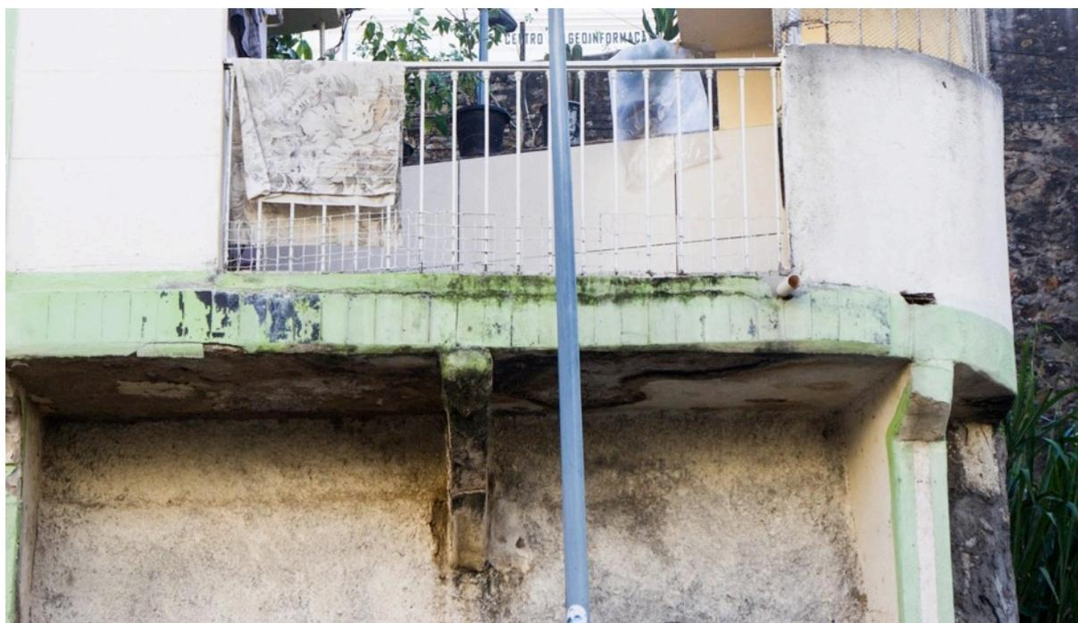
**Figura 45: Gambiarra Carioca 12 - "Puxadinho" denunciado pelo revestimento.**
