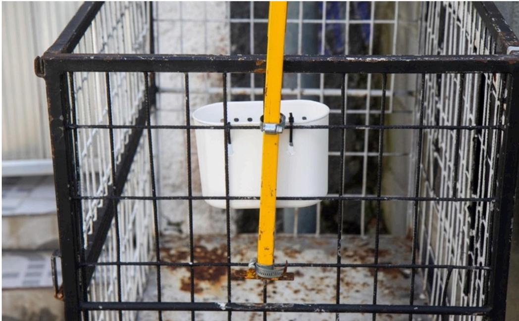
**Figura 20: Gambiarra Carioca 01 – detalhe do porta-treco preso com abraçadeiras.**
