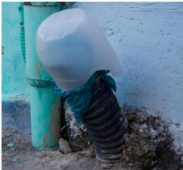
**Figura 41: Gambiarra Carioca 10 - recipiente de plástico como proteção de cabeamento.**
