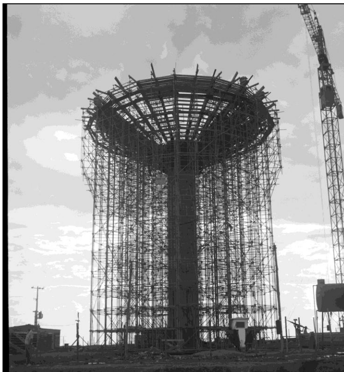
Figura 9: Construção da Caixa d'água - Ceilândia, 11/01/1973.
