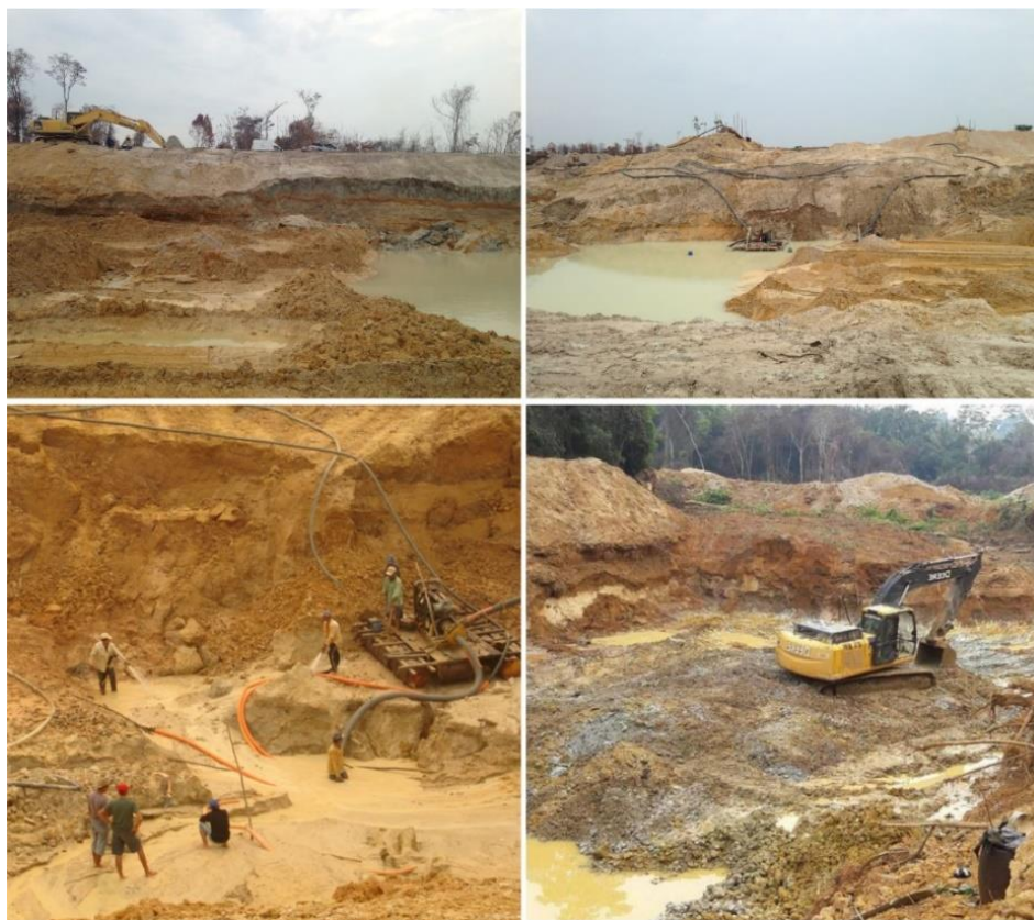
Figura 6.3 Fotografias evidenciam as cavas realizadas nos paleoterraços do rio Peixoto de Azevedo para a exploração de ouro. Nas fotos notam-se uso de retroescavadeira e jatos de água para escavação, destorroamento e concentração do minério para sucção das dragas.
