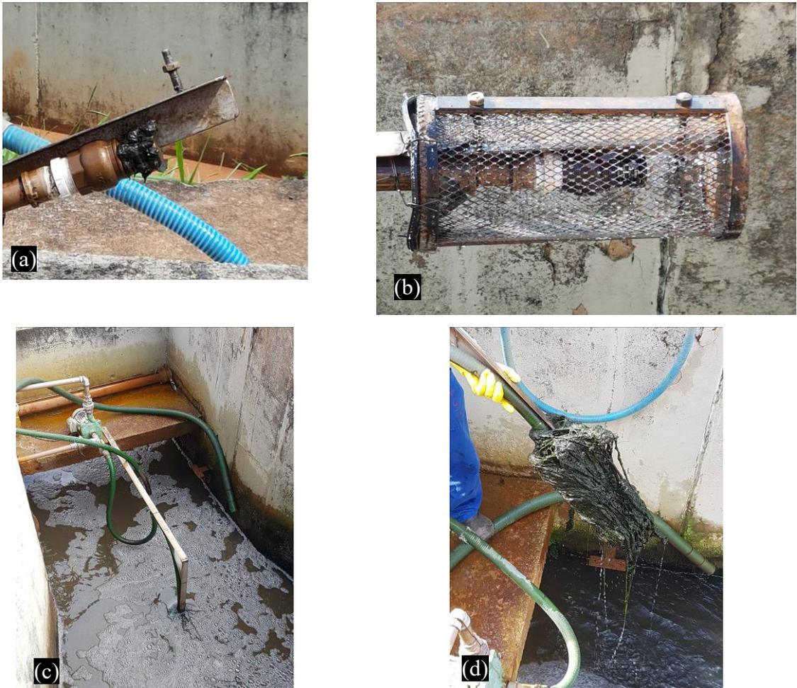
Figura 5.1- Imagens do sistema de coleta de efluentes para alimentação da IP-UF: (a) Crivo obstruído; (b) Cesto de proteção do crivo limpo; (c) Suporte metálico de posicionamento e fixação do mangote de captação e do cesto de proteção do crivo; e (d) Cesto obstruído.
