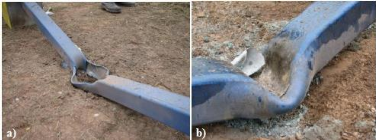
Figura 2.2 – Dano local em pilar tubular de aço sem preenchimento (a) e preenchido por concreto (b) por explosão próxima, Ngo et al. (2014).
